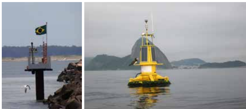
Figura 4 – Instalações do Sistema de Monitoramento da Costa – SiMCosta: Boia Meteorocenaográfica fundeada na Baía de Guanabara e Estação Maregráfica instalada nos Molhes do Rio Grande (RS).
