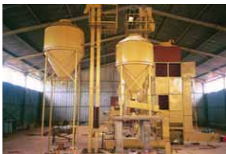
Instalações da fábrica de ração de Benjamin Constant, 2004
