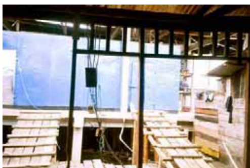
Armazém frigorífico em Letícia (Agosto, 2001)
