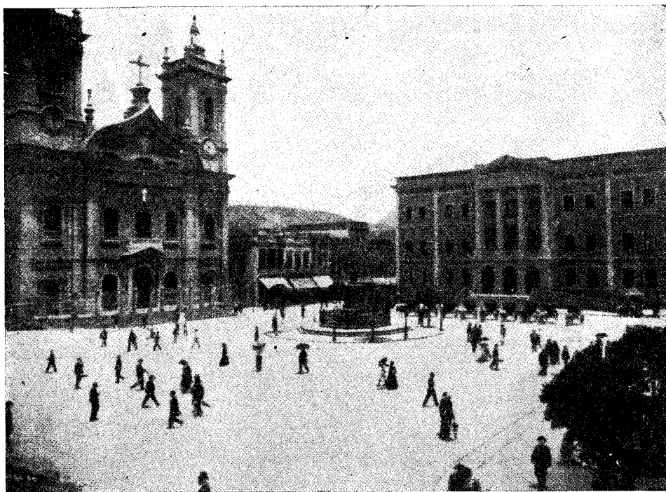
Fig. 6 — Escola Politécnica e Igreja de São Francisco de Paulo, na Administração Passos. Revista Municipal de Engenharia — vol. 8 — julho de 1941 — n.º 4 — Secretaria-Geral de Viação e Obras.
