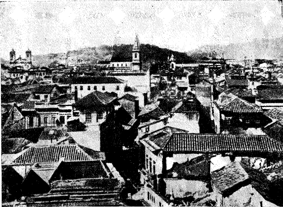
Fig. 10 — A antiga rua do Sacramento, hoje avenida Passos. Revista Municipal de Engenharia — vol. 8 — julho de 1941 — Secretaria-Geral de Viação e Obras.
