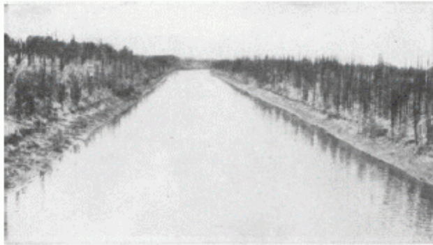
(a) k_{St} = 50 \text{ m}^{1/3}/\text{s} , Betonkanal mit grober Oberfläche (b) k_{St} = 36 \text{ m}^{1/3}/\text{s} , Fluss mit Kies- und Sandsohle (c) k_{St} = 12 \text{ m}^{1/3}/\text{s} , stark verwachsenes Bachbett
