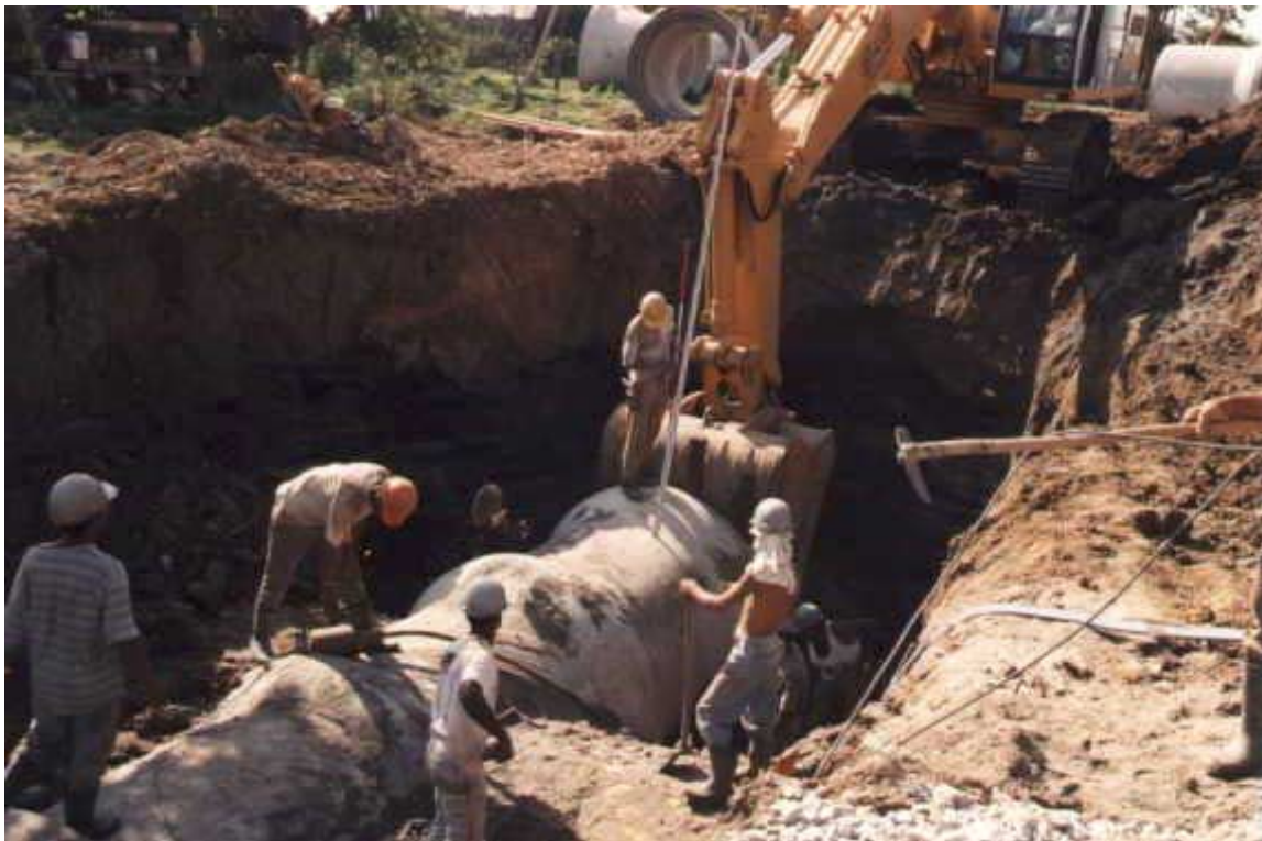
Abb. 51 - Erstellung des Hauptsammlers
