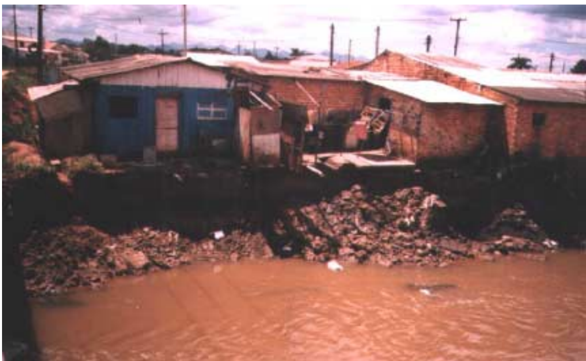
Abb. 29 - Erosierte Uferböschung des Flusses Atuba, SD
