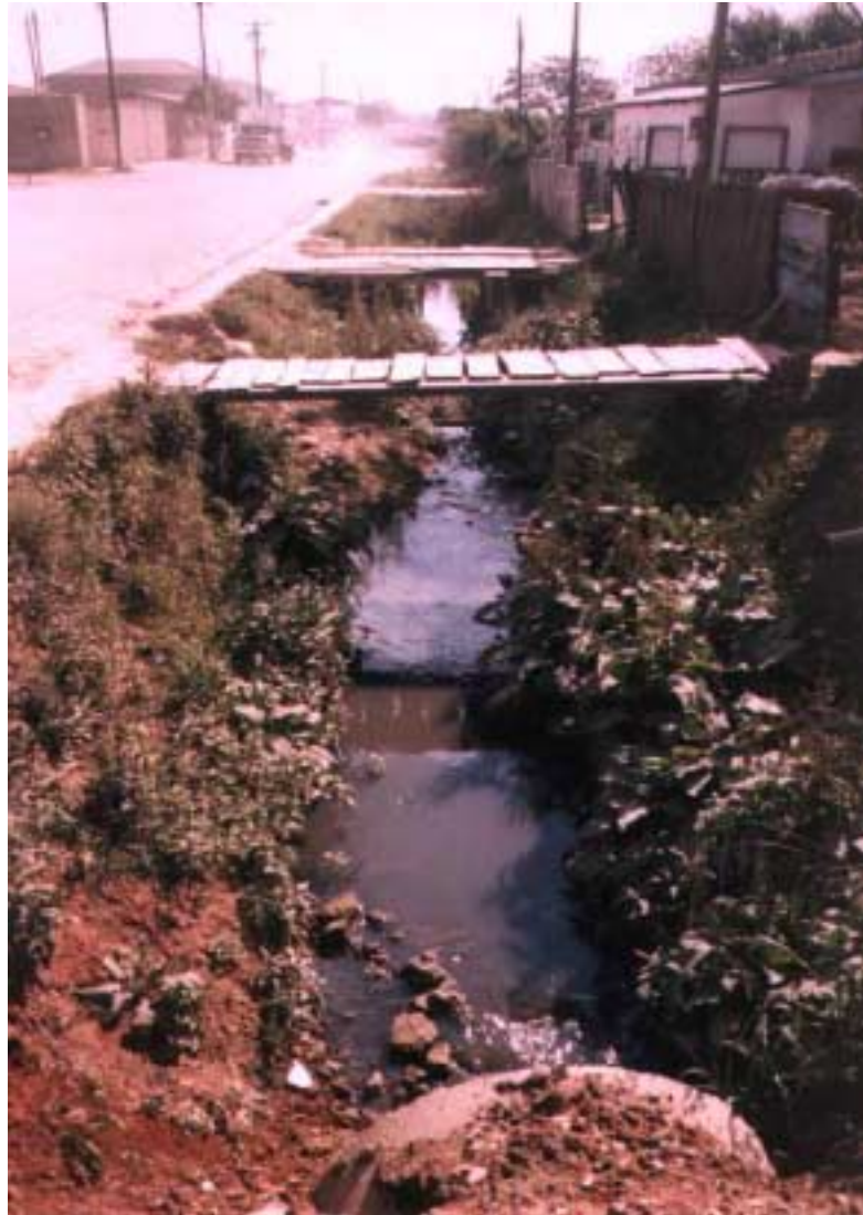
Abb. 15 - Abwassergraben mit Hausanschluss
