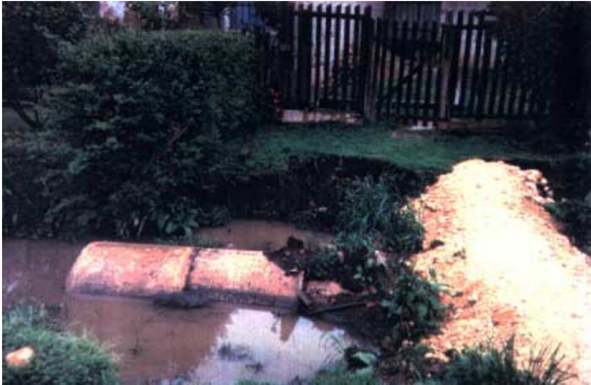
Abb. 26 - Falsch verlegte Rohre verursachen Aufstauungen und Erosion, SD
