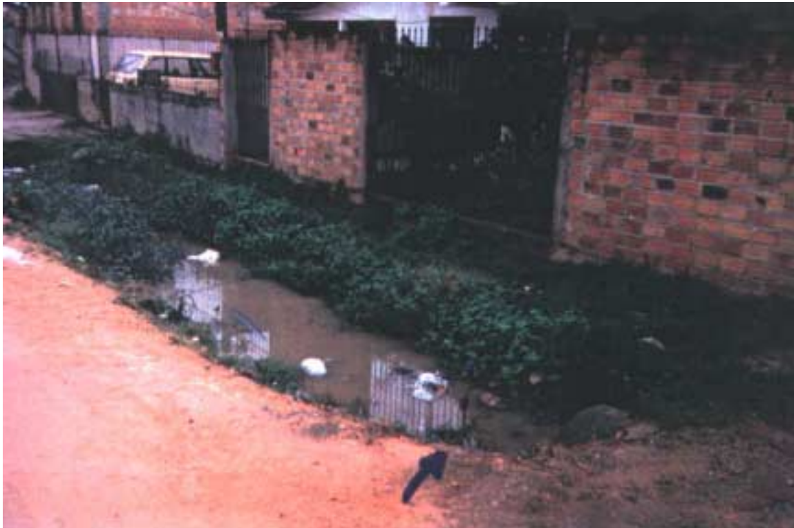
Abb. 31 - Abwassergraben mit sichtbarer Trinkwasserleitung, SD
