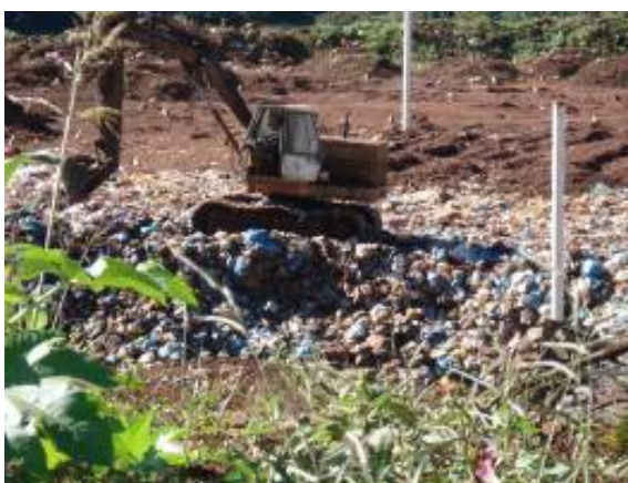
FIGURA 1 - COMPACTAÇÃO DOS RESÍDUOS SÓLIDOS EM CÉLULAS DE ATERRO FONTE: SENAI-CIC/CETSAM – CSM - RESÍDUOS SÓLIDOS
