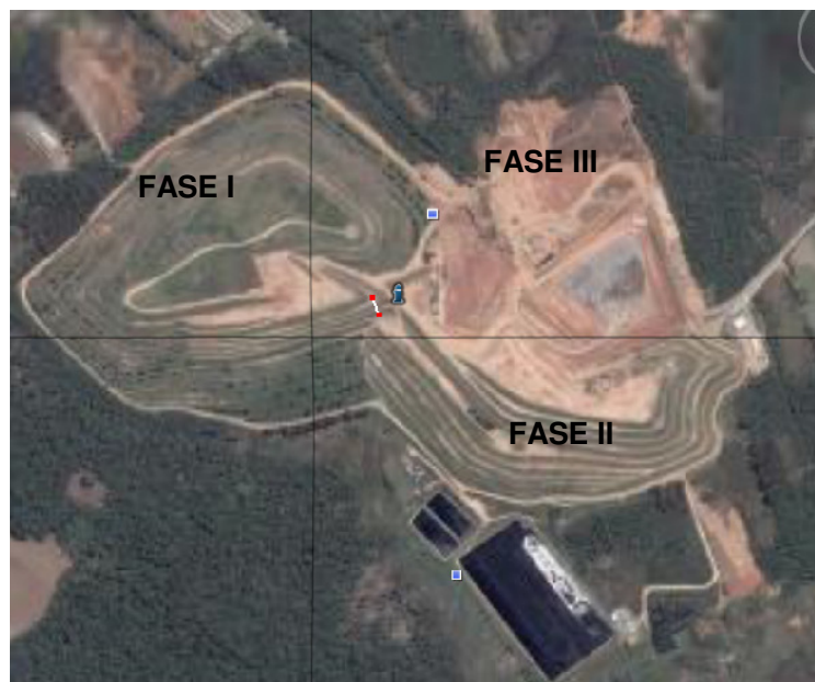
FIGURA 2.2 – IMAGEM DE SATÉLITE DO ATERRO SANITÁRIO DE CURITIBA
