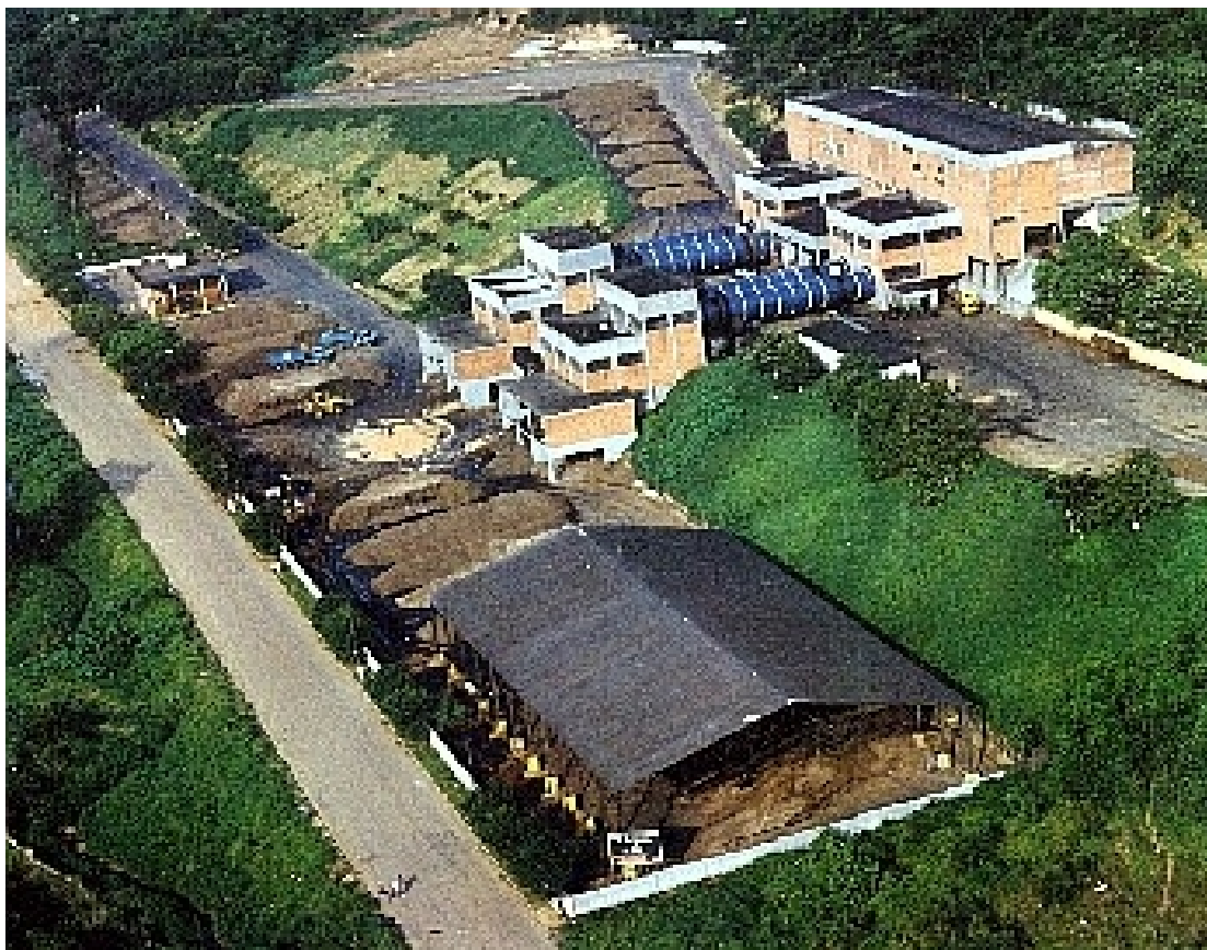
FIGURA 2.12 – USINA DE COMPOSTAGEM SISTEMA DANO (SÃO MATEUS / SP)
