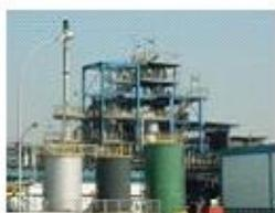
A unidade de Incineração funciona 24 horas por dia, com capacidade de destruição segura de resíduos sólidos, líquidos e pastosos de alta periculosidade. É o processo de destruição via oxidação térmica realizado em altas temperaturas – de 800 a 1.200° C. A unidade de Incineração opera de acordo com os conceitos de inovação e sustentabilidade.
