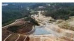
É uma solução ambientalmente segura para a disposição final de resíduos classes I,IIA e IIB. Os aterros da Essencis são construídos com tecnologia de última geração de impermeabilização de solos, adotam a técnica de confinamento total de resíduos, possuem drenagem e tratamento de efluentes líquidos e gasosos e são continuamente monitorados para a máxima segurança ambiental.
