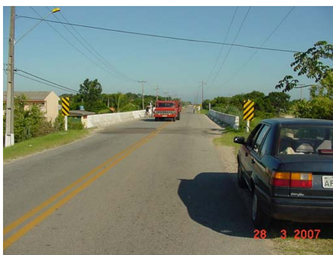
Figura 5.3.187: Estrada Ponta do Poço. Ponte Fonte: Roberto Sampaio, 28/03/2007.
