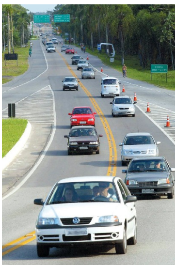
Figura 5.3.27: PR-407 no acesso à PR-277. Operação retorno. Fonte: Ecovia 2007
