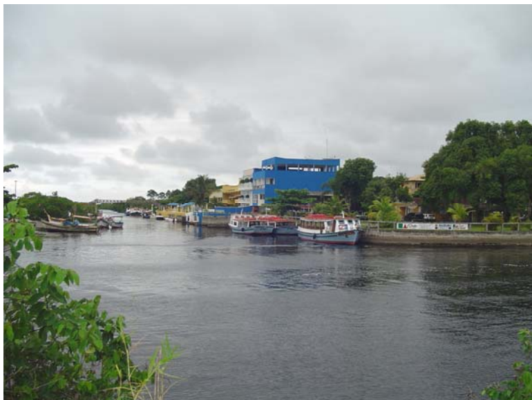
Figura 5.3.4: Marinas no canal do DNOS. Pontal do Sul (Fonte: Pierri 10/02/07).
