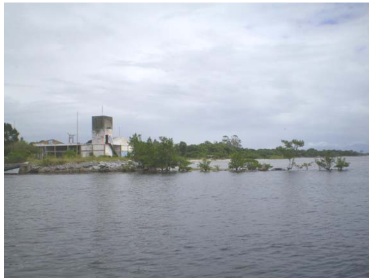
Figura 5.3.3: Ponto de observação na saída do canal do DNOS. Antiga cooperativa. Pontal do Sul (Fonte: Soares 12/02/07).
