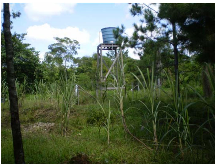
Figura 5.3.59: Reservatório de água (Foto de Chang, 03/02/2007)
