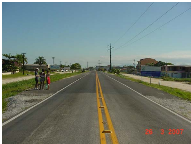
Figura 5.3.10: Exemplo de trecho homogêneo: acostamentos e via de trânsito local nos dois lados da estrada (PR-412, Shangri-Lá) Fonte: Roberto Sampaio 26/03/2007.
