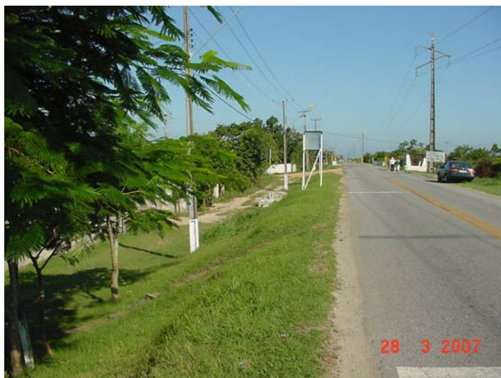
Figura 5.3.189: Estrada Ponta do Poço. Barranco sem acostamento na área urbanizada (1) Fonte: Sampaio, 28/03/2007
