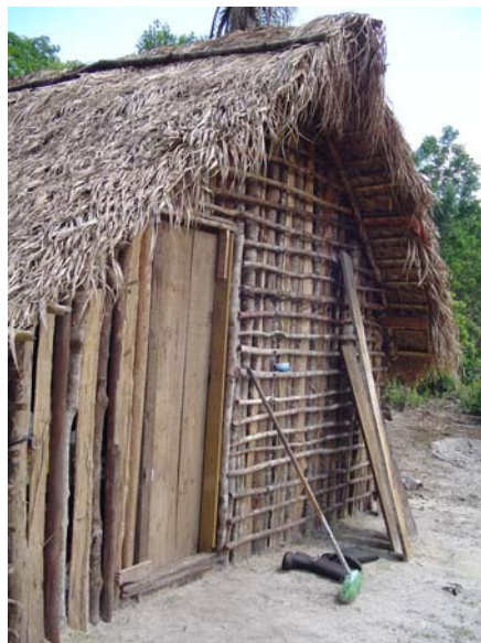
Figura 5.3.52: Moradia 1 (Foto de Pierri, 03/02/2007).
