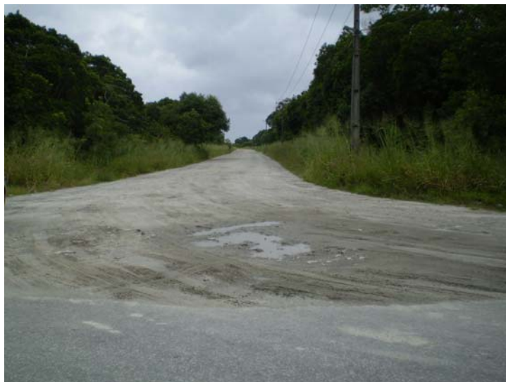
Figura 5.3.147: Estrada Ponta do Poço. Caminho de cascalho rumo ao local do TCPP. Fonte: Pierri 13/04/2007
