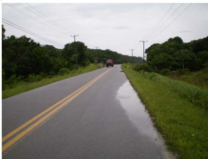
Figura 5.3.190: Estrada Ponta do Poço. Barranco sem acostamento na área não urbanizada (2) Fonte: Pierri, 26/04/2007
