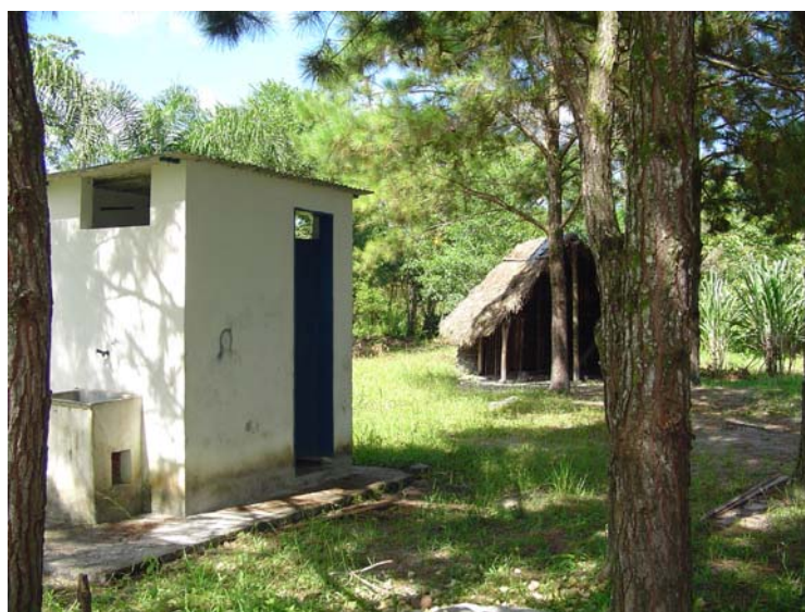
Figura 5.3.58: Banheiro de alvenaria (Foto de Pierri, 03/02/2007).
