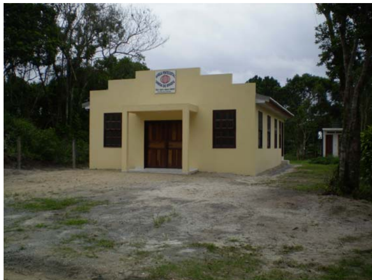
Figura 5.3.206: Reassentamento de 2003. Igreja nova. Fonte: Pierri 13/04/2007.
