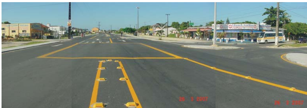
Figura 5.3.117: Trecho agenciado da rodovia PR-412 (Fonte: Roberto Sampaio 2007)
