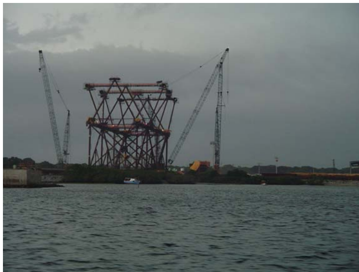
Figura 5.3.77: Plataforma petroleira marinha em construção. Pontal do Paraná (Fonte Pierri 24/11/2005).
