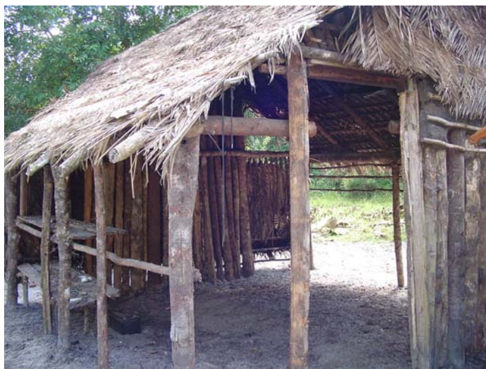
Figura 5.3.57: Local de jantar em construção (Foto de Pierri, 03/02/2007).
