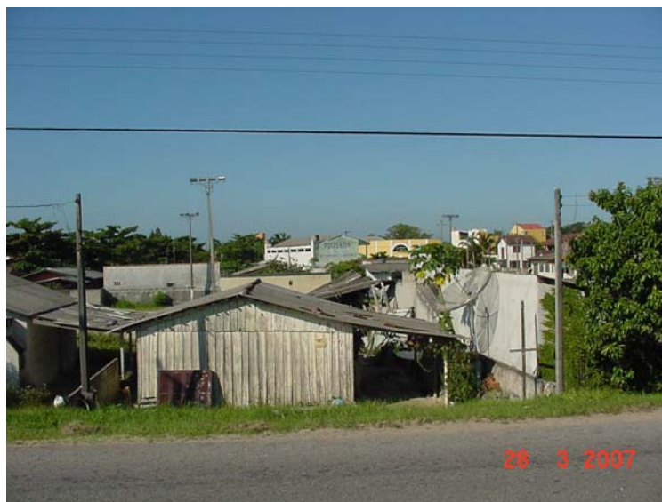
Figura 5.3.182: Estrada ponta do poço. Proximidade de imóveis à estrada Fonte: Sampaio, 28/03/2007
