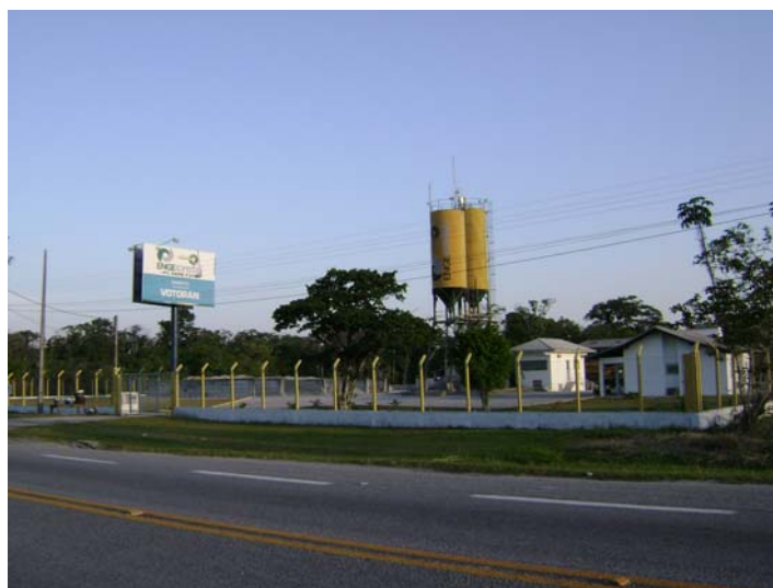
Figura 5.3.75: Empresa produtora de concreto. Pontal do Paraná (Fonte Pierri 09/06/2007).
