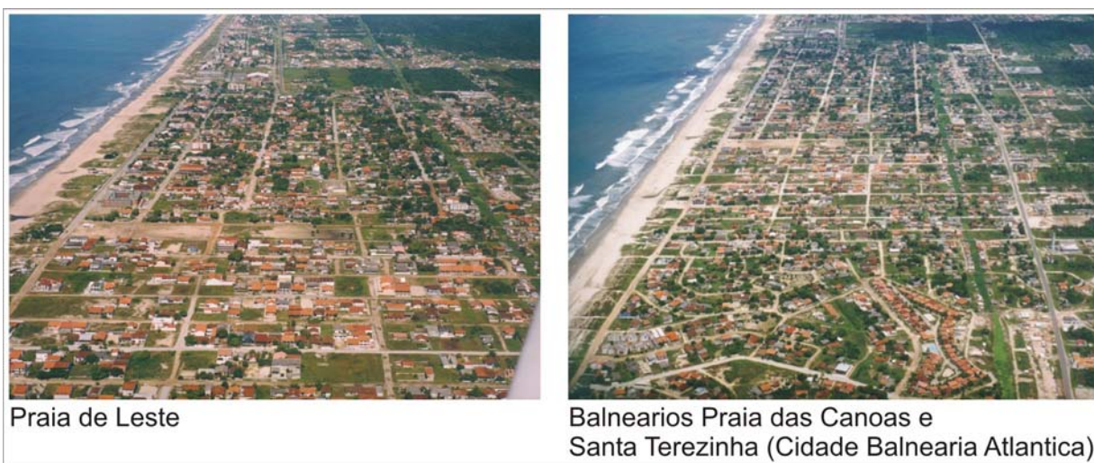
Figura 5.3.106: Fotografias aéreas oblíquas de Pontal do Paraná, datadas de depois do ano 2000, evidenciando a predominância da paisagem construída horizontal (Fonte: arquivo da Prefeitura de Pontal do Paraná)
