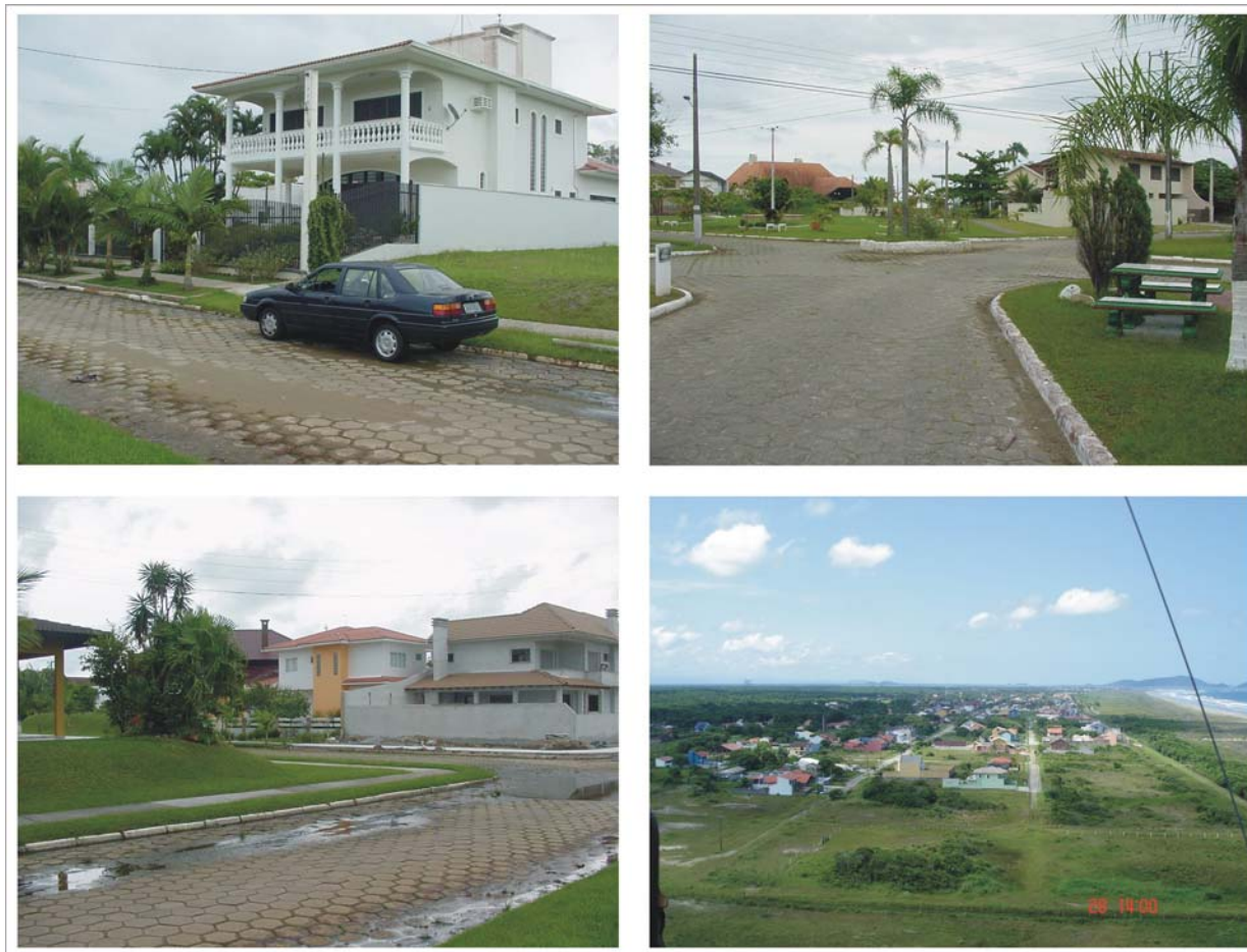
Figura 5.3.118: Edificações no Balneário Atami e vista aérea oblíqua do “Atami II” (Fonte: Roberto Sampaio 2005 e Carlos Bonatto (foto aérea 2005))
