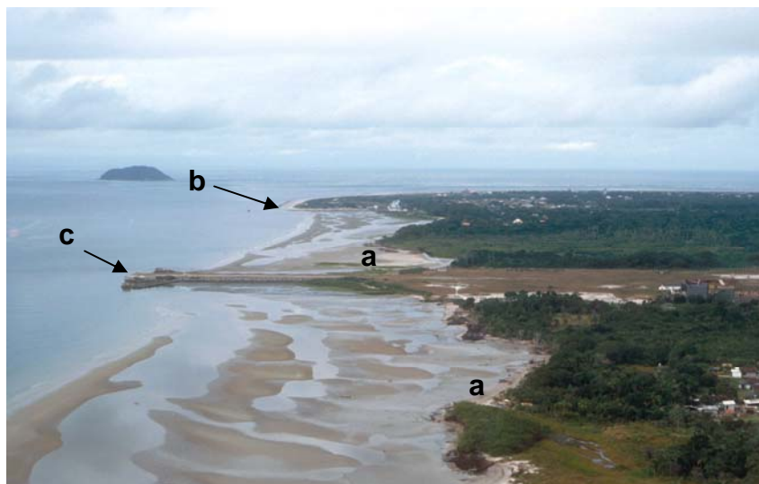
Figura 24: Praia estuarina sob intenso processo erosivo (a) decorrente de intervenções próximas, notadamente o Canal do DNOS (b) e o píer da Techint (c).
