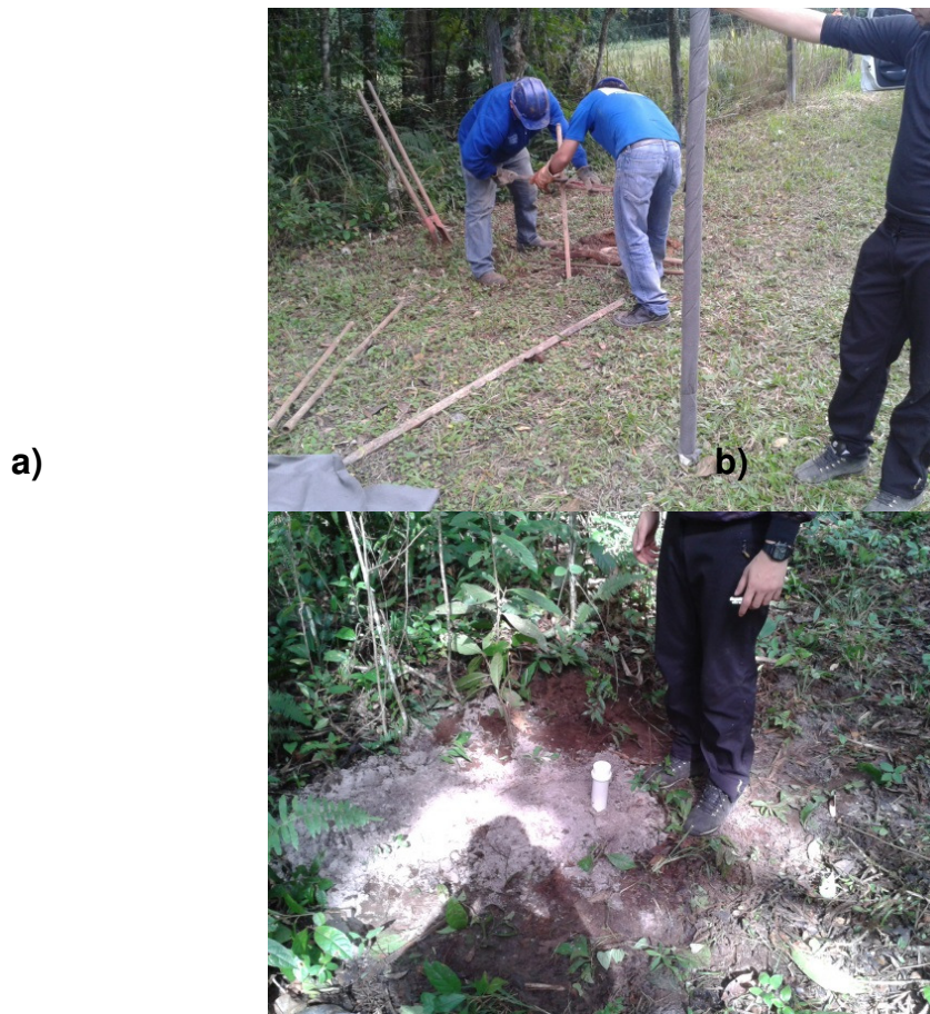
Figura 6-55 - Procedimento de instalação do poço piezômetro: a) Perfuração para instalação de poço piezômetro, utilizando trado helicoidal. Em primeiro plano aparece a coluna de revestimento com o filtro envolvido por manta de bedin, aguardando para ser instalada na perfuração; b) Poço piezômetro já instalado e em operação.
