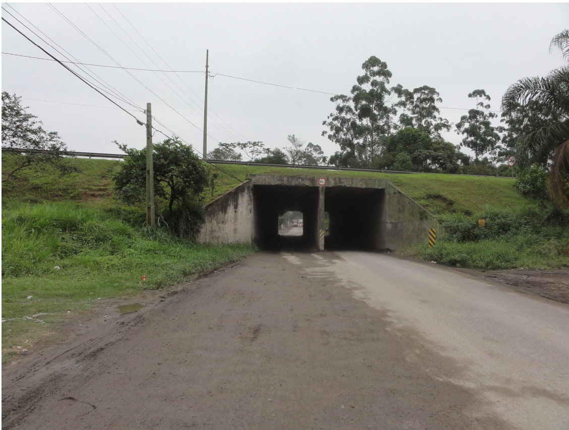
Figura 3-36 - Passagem da Avenida Sen. Atílio Fontana sob a BR-277.
