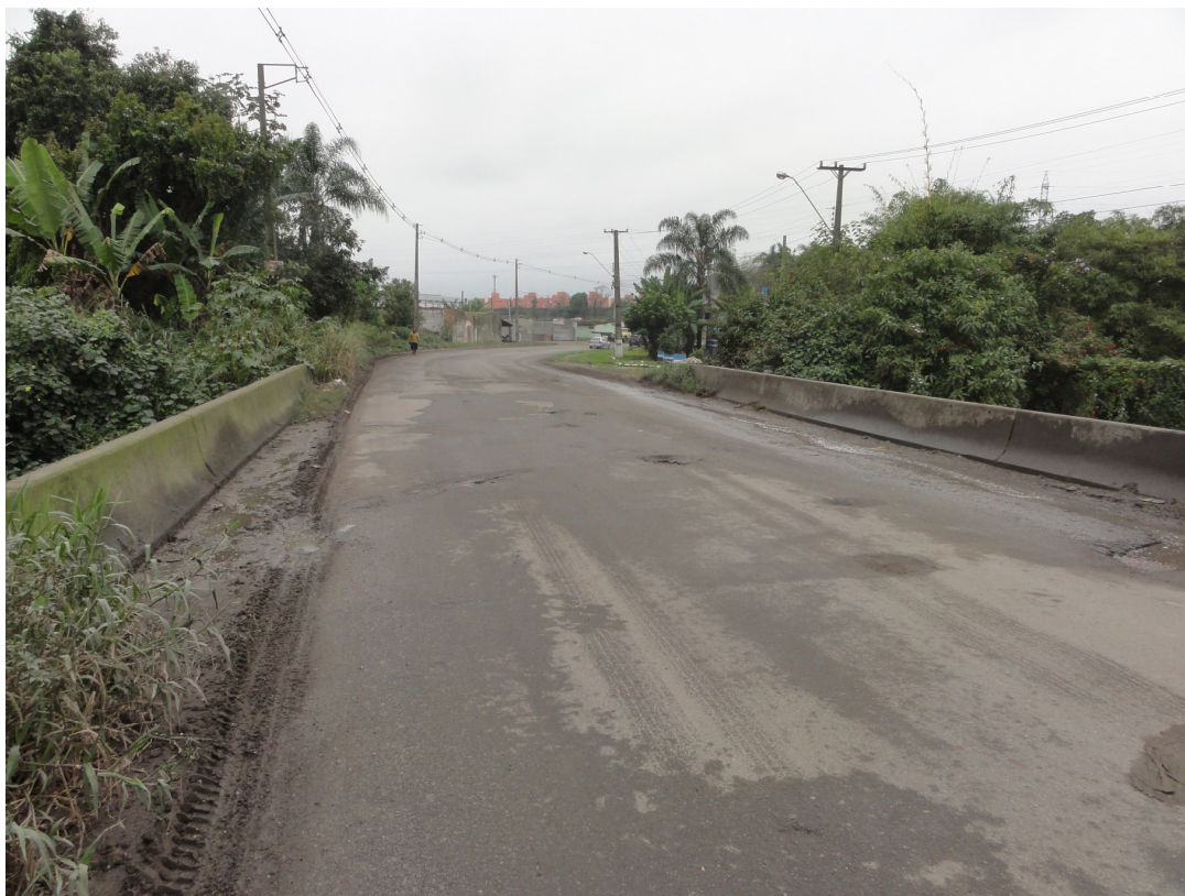
Figura 3-38 - Ponte sobre o Rio Emboguaçu.
