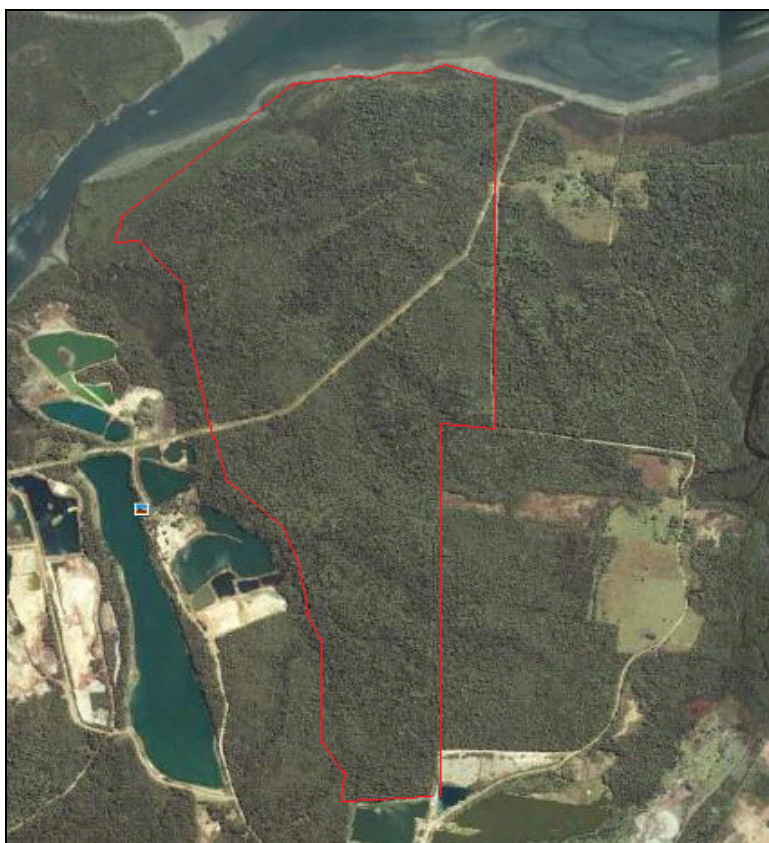
Figura 6-166 - Perímetro do empreendimento.
