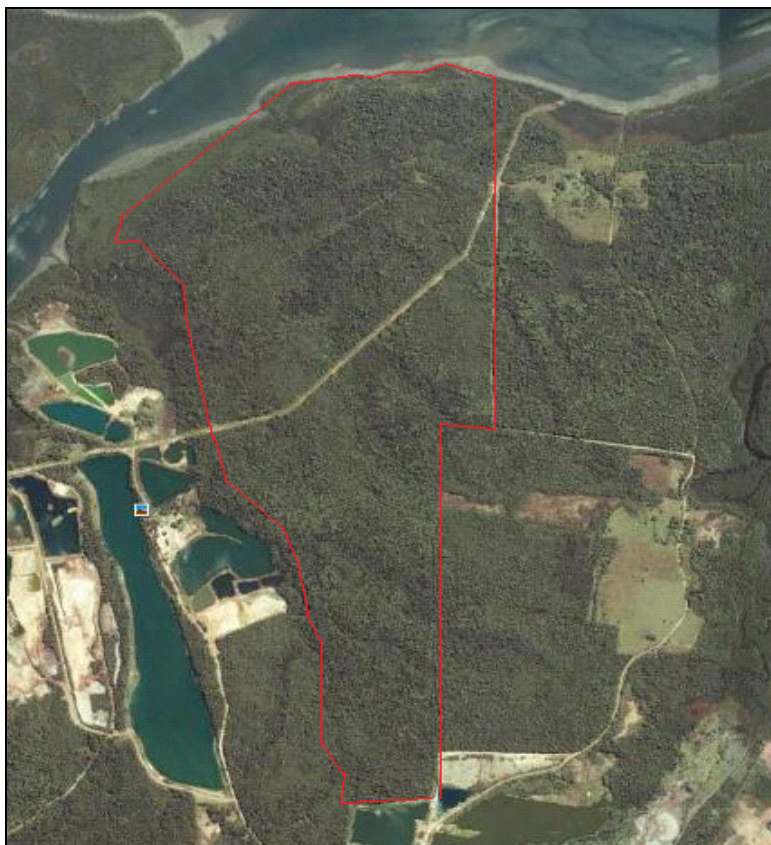
Figura 3-1 - Imagem de satélite (Google Earth) do perímetro global dos imóveis que compõem a área do empreendimento – Paranaguá - PR
