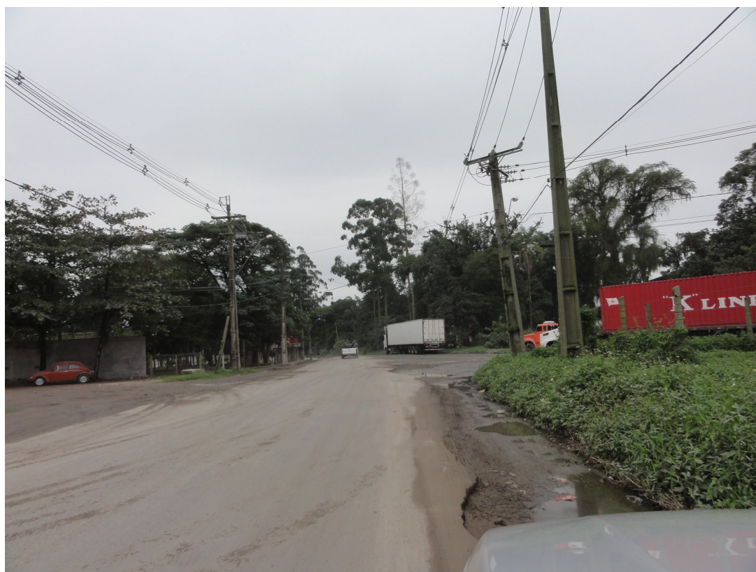
Figura 3-39 - Av. Sen. Atílio Fontana entre a BR-277 e Estrada Velha de Alexandra.
