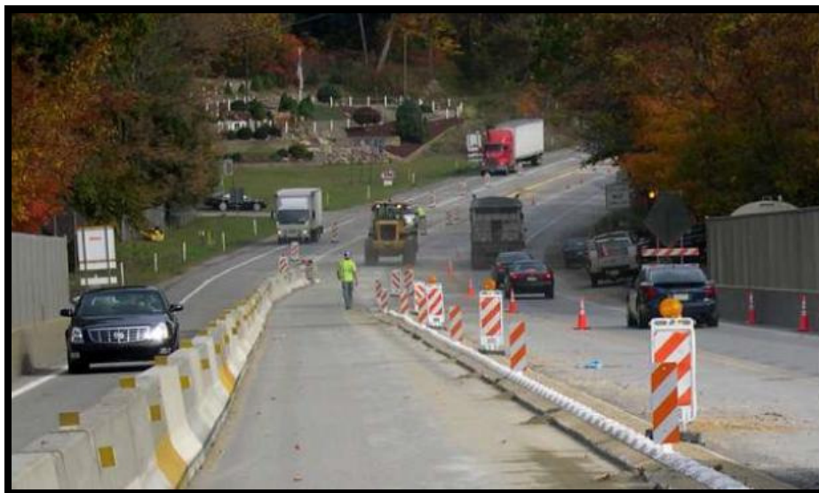
Figura 7-3 - Exemplo de canalização de tráfego com o uso de barreiras plásticas e marcadores de perigo
