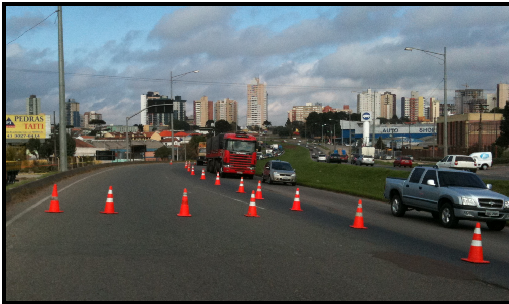
Figura 7-2 - Exemplo de canalização do tráfego com a utilização de cones.
