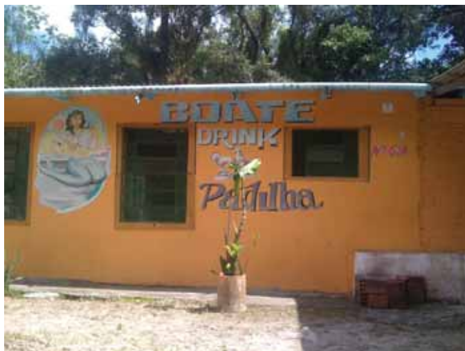
Foto 6-48 – Moradias e comércio localizados sobre a calçada e parte da pista de rolamento contíguos ao terreno do empreendimento
