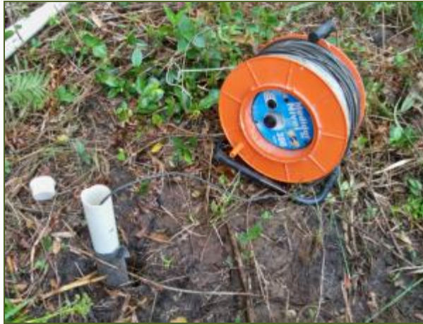
Figura 4-19: Obtenção da medida do nível da água do poço de monitoramento.
