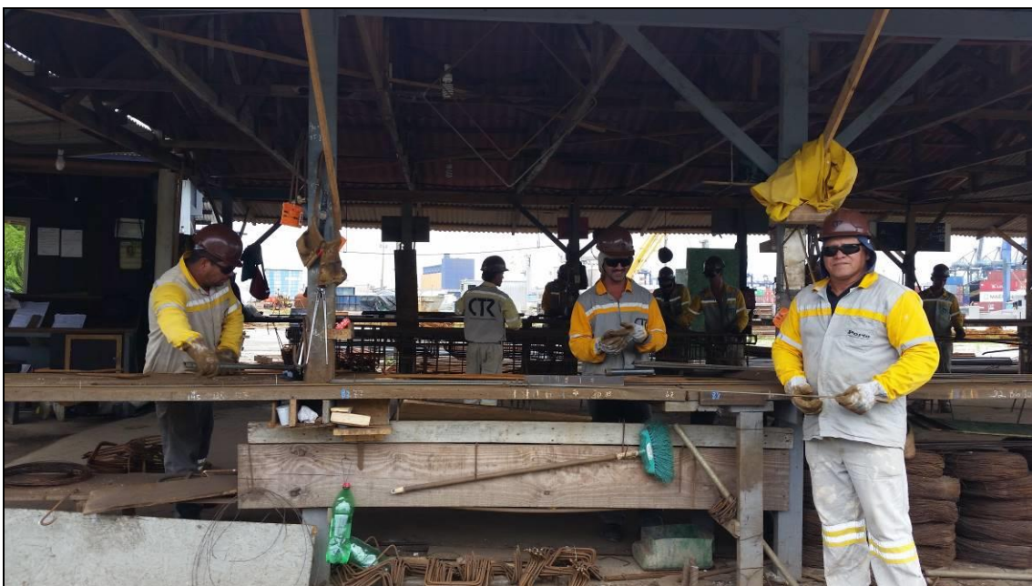
Figura 54. Local de corte e dobra de estruturas de ferro.
