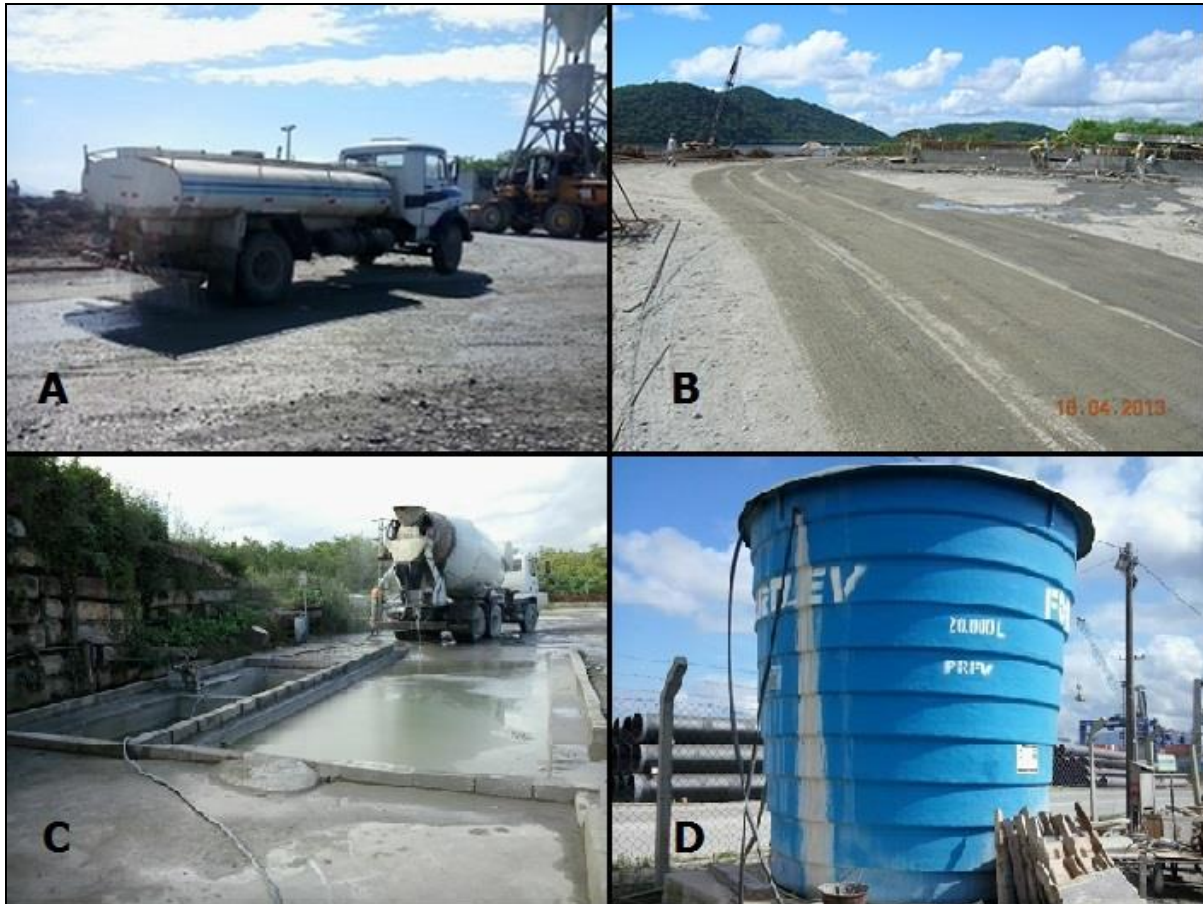
Figura 61. A) Caminhão Pipa; B) Via Interna do Canteiro de Obras; C) Rampa de lavagem do Caminhão Betoneira; e D) Caixa D'Água.
