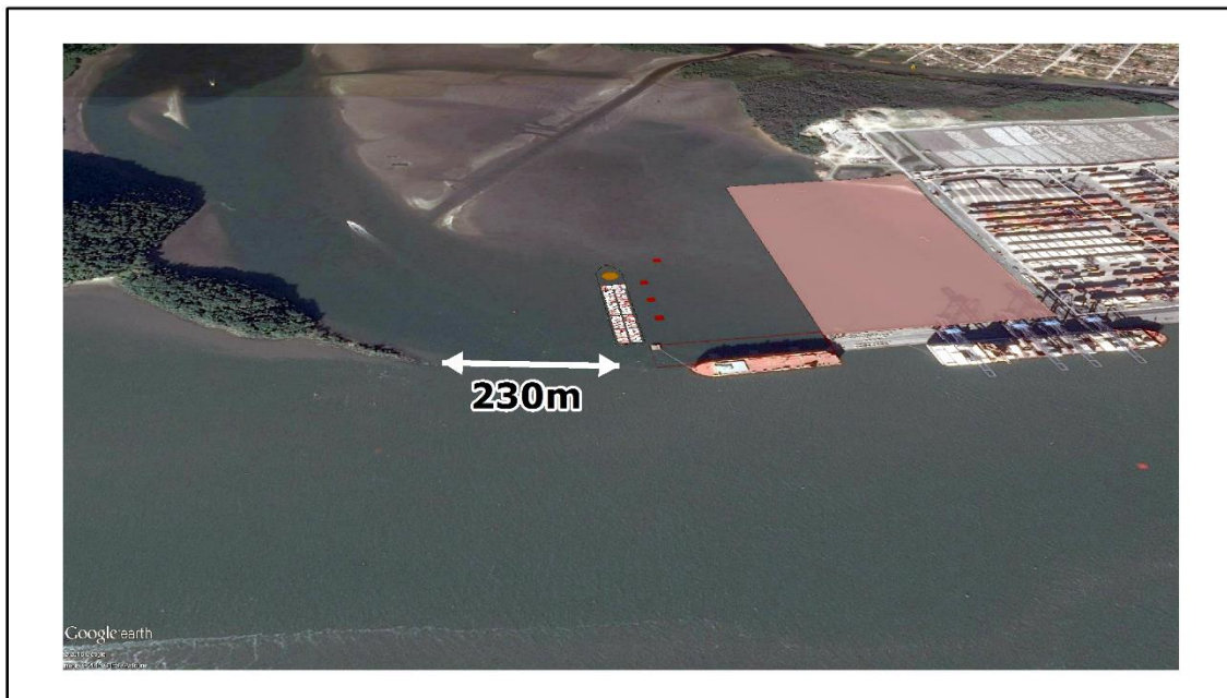
Figura 638. Seção livre do canal da Cotinga com 230 metros. Observa-se o navio atracado nos novos dolphins, oportunidade que haverá uma redução de 40 metros na seção do canal, com a atracação de um navio roll on- roll off .
