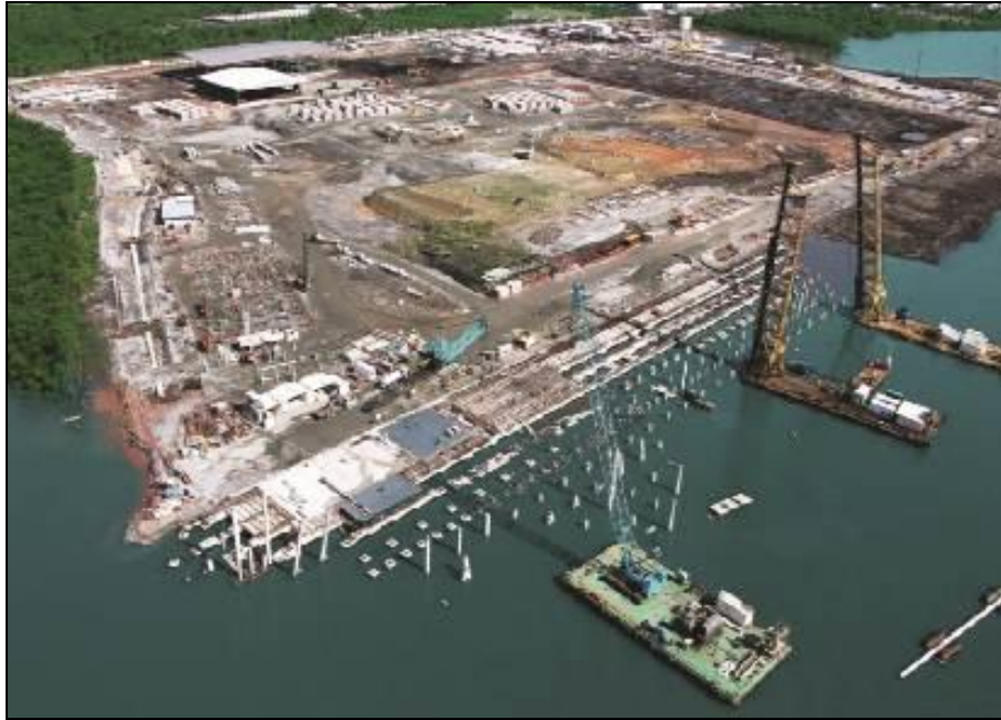
Figura 18. Bate estacas sobre flutuantes.
