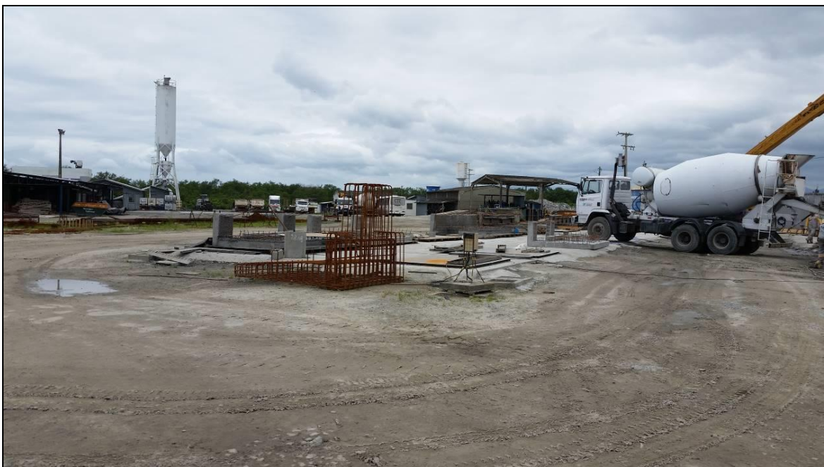
Figura 56. Área de preparo de concreto pré moldado.
