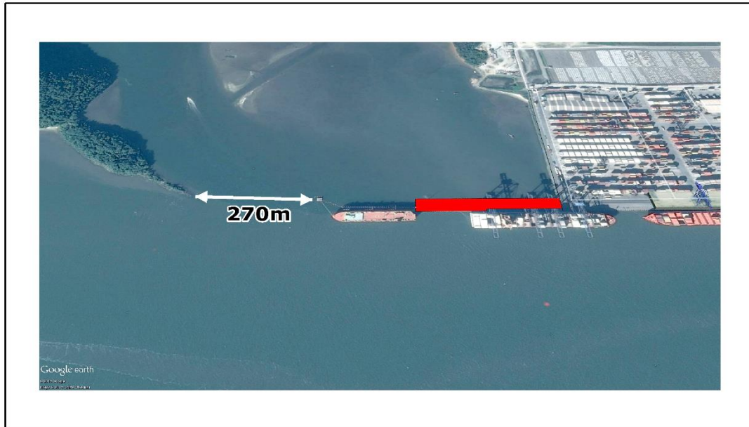
Figura 636. Ampliação do cais leste com a diminuição da seção livre do canal da cotinga para 270 metros.
