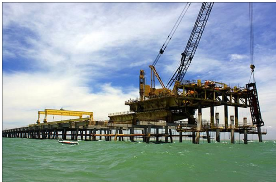
Figura 19. Bate estacas tipo Cantitravel .
