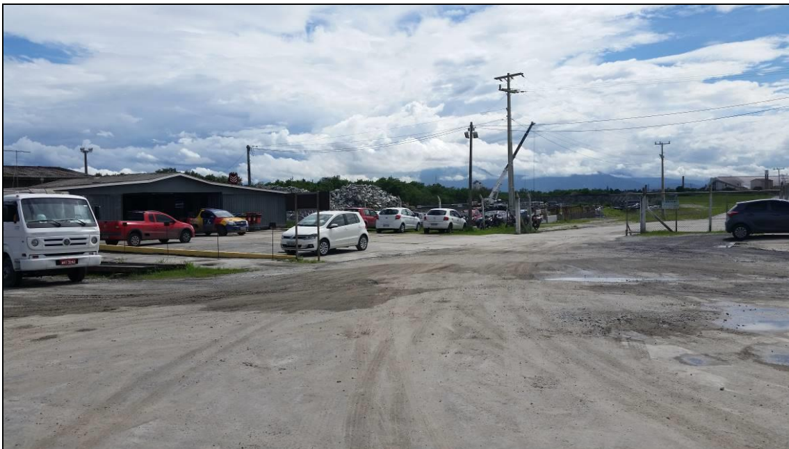
Figura 46. Acesso ao canteiro de obras e área de estacionamento para os operários e demais colaboradores.
