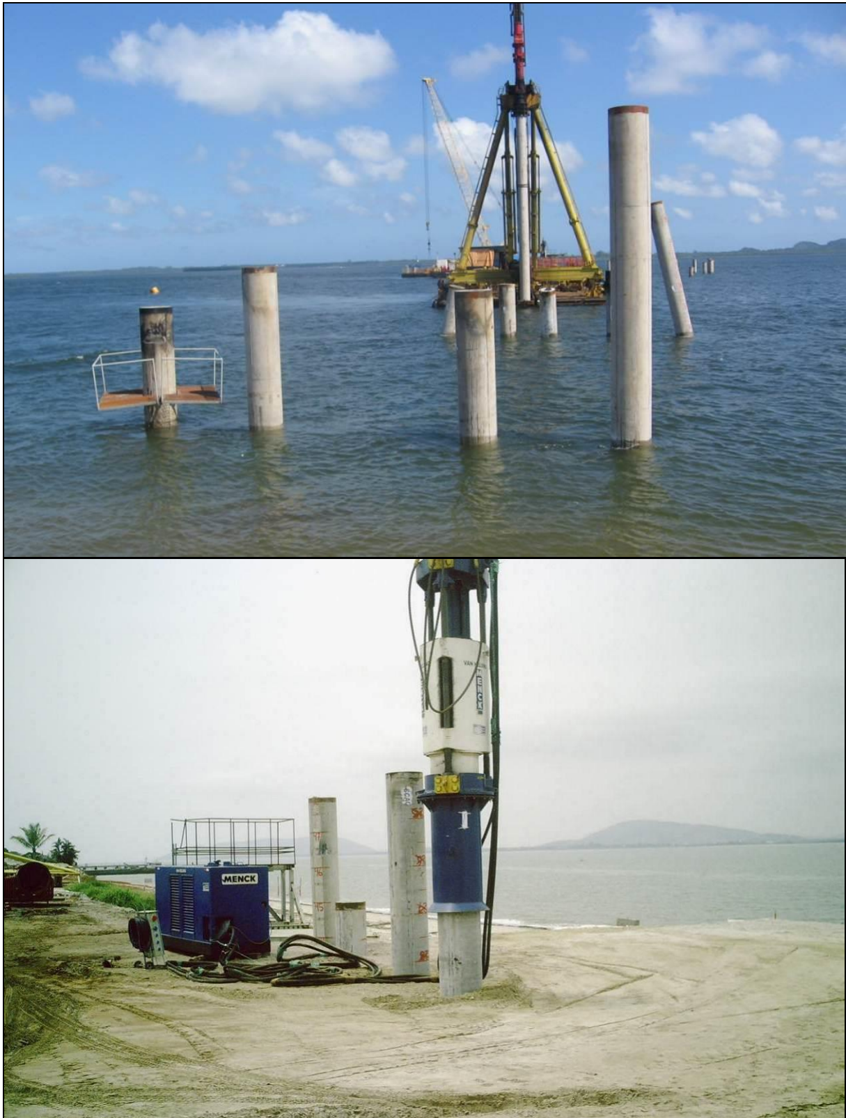
Figura 17. Estacas de concreto pré-moldado cravadas em mar e terra.
