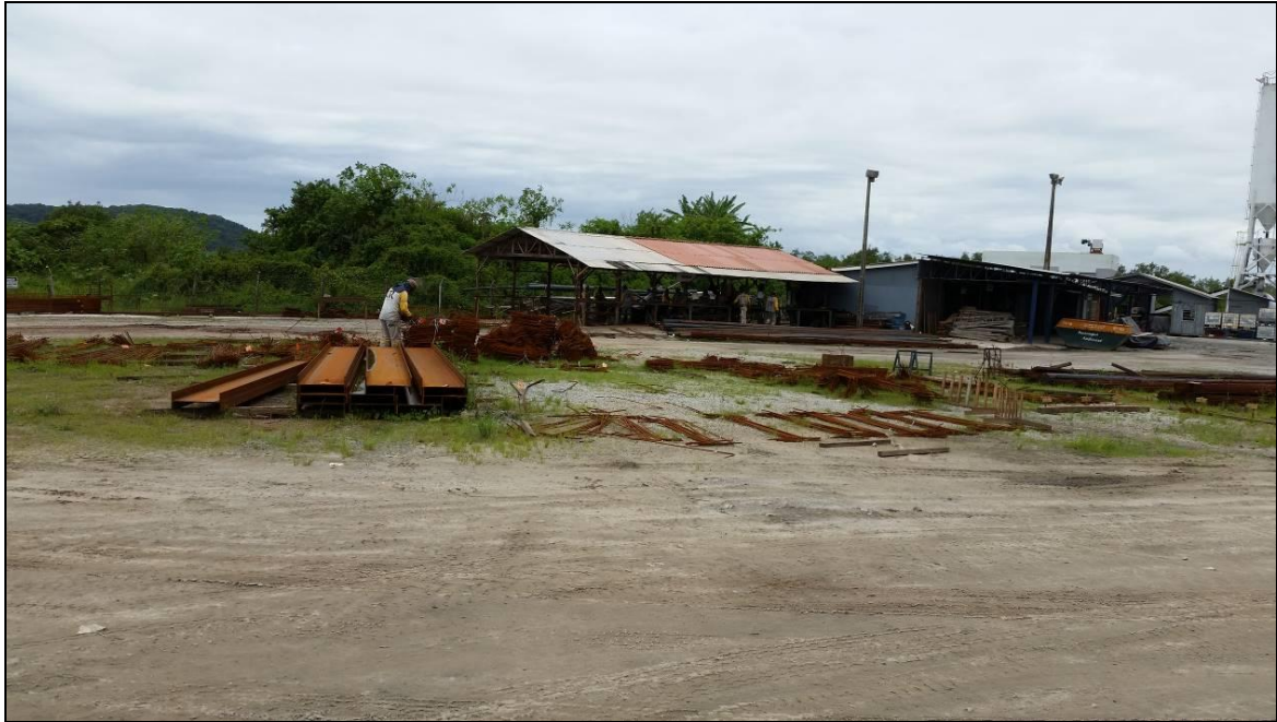
Figura 55. Área de montagem de armaduras.
