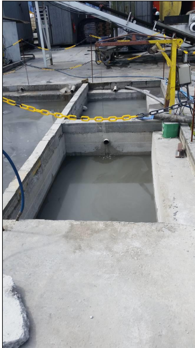
Figura 57. Caixas decantadoras de água e areia.
