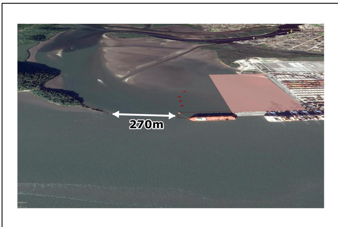
Figura 622. Projeto de complementação das obras de ampliação do TCP, onde se observa a seção livre de 270 metros no canal da Cotinga.
