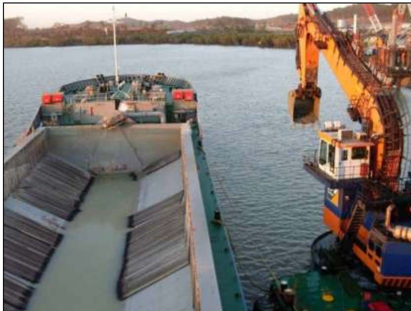
Figura 30. Vista superior da cisterna de um batelão. Escavadeira, à direita, retira o material do fundo e insere dentro do batelão para este se deslocar ao local de despejo. Fonte: dredgepoint.com.
