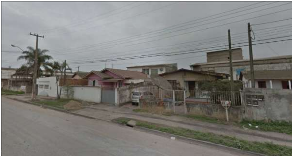
Figura 595. Aglomerado populacional localizado à margem da rua Manoel Bonifácio – utilizada pelos caminhões de contêineres para acesso ao TCP.
