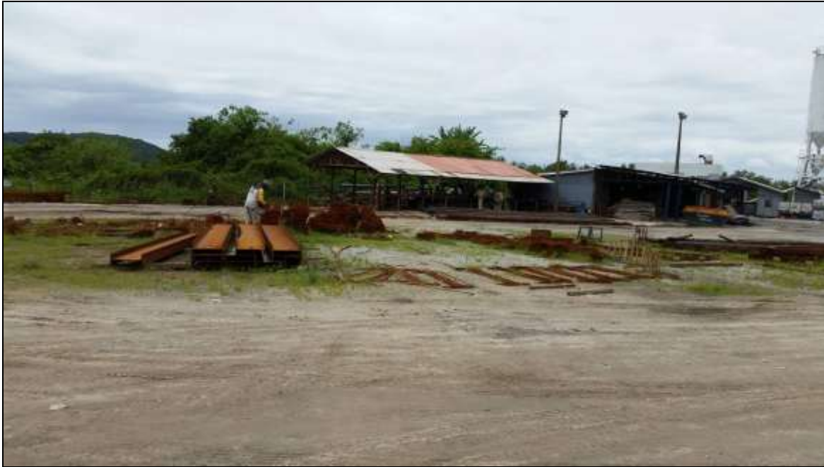
Figura 53. Área de montagem de armaduras.
