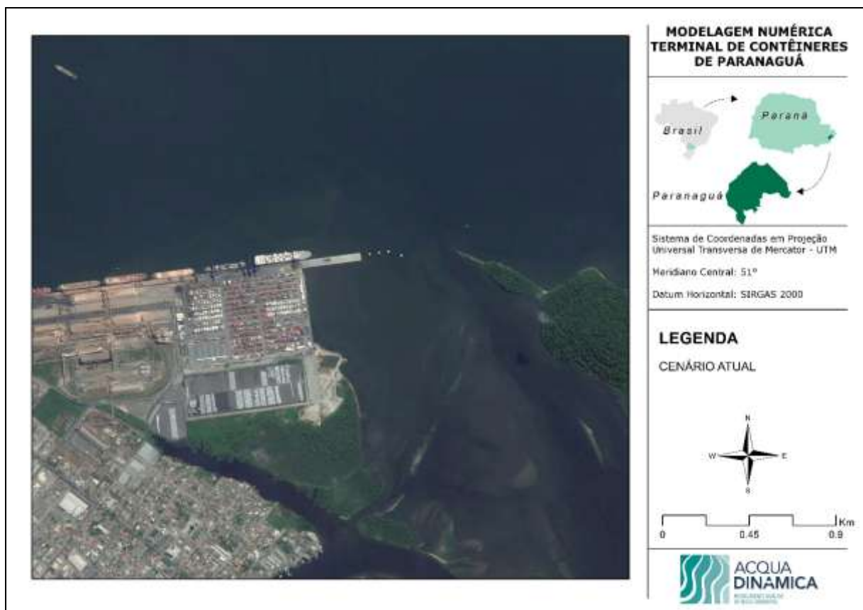
Figura 201. Localização da área de estudo com detalhe da configuração atual do Terminal de Contêineres de Paranaguá - TCP, baía de Paranaguá.
