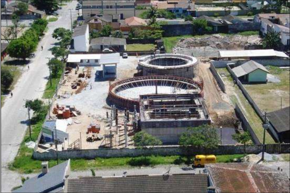
Figura 544. Processo de construção da Estação de Tratamento de Efluentes no bairro Costeira. Fonte: www.blogdaluciane.com.br (2014).
