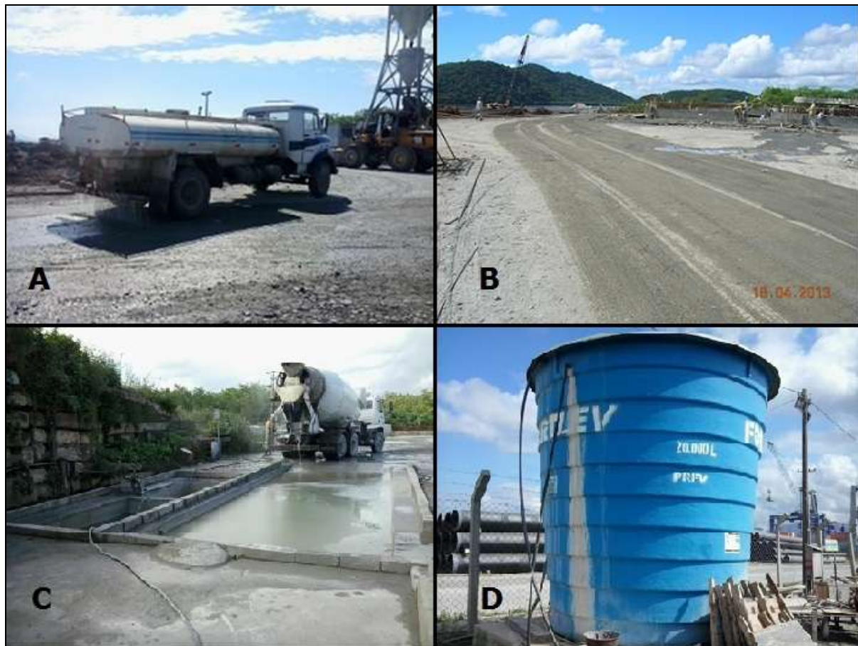
Figura 59. A) Caminhão Pipa; B) Via Interna do Canteiro de Obras; C) Rampa de lavagem do Caminhão Betoneira; e D) Caixa D' Água.
