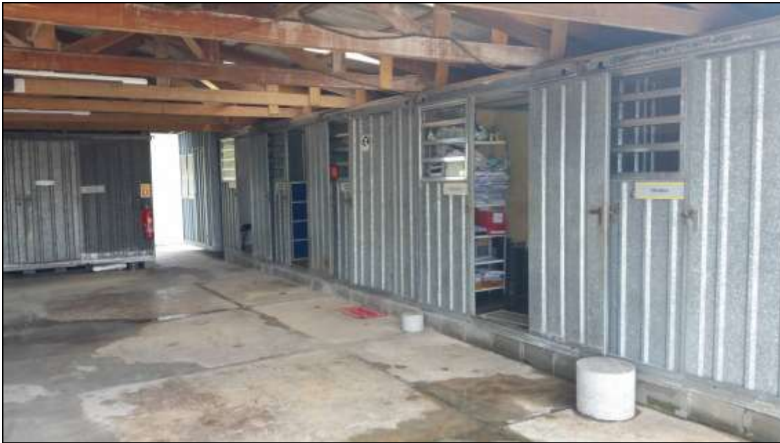
Figura 46. Imagem interna das estruturas de apoio administrativo.
