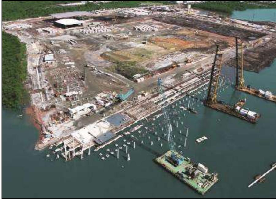
Figura 17. Bate estacas sobre flutuantes.
