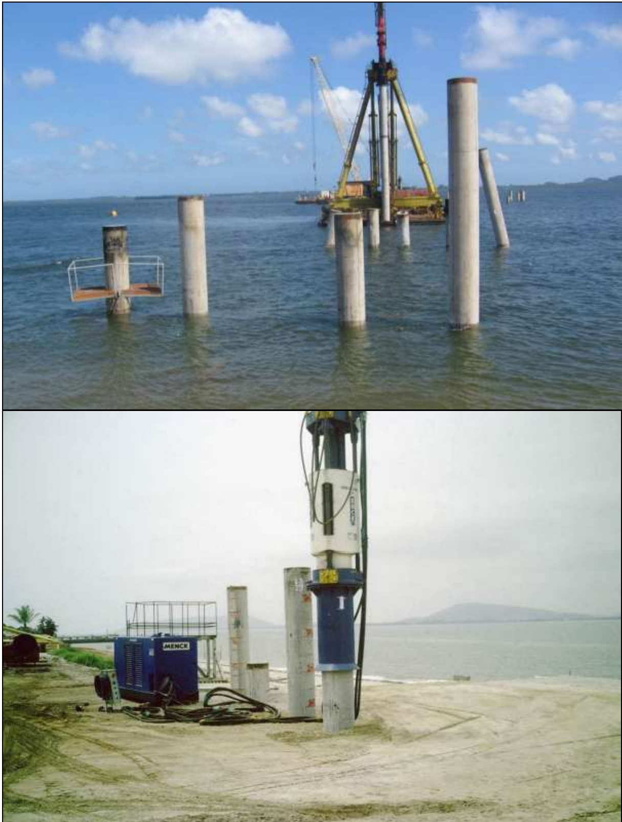
Figura 16. Estacas de concreto pré-moldado cravadas em mar e terra.
