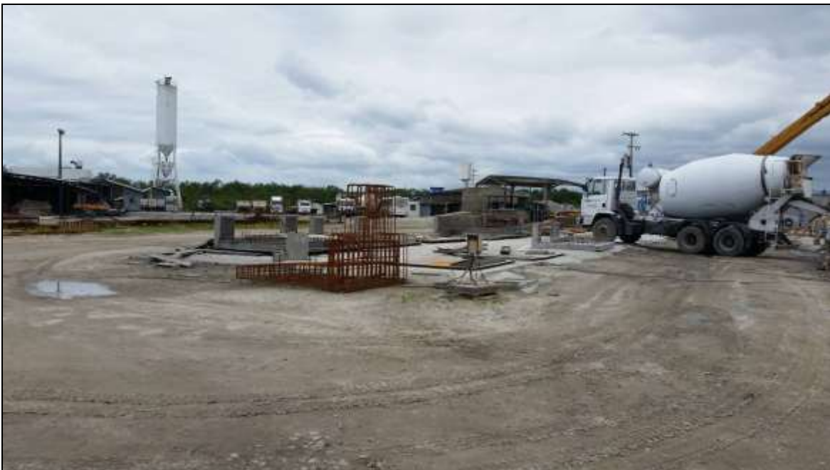
Figura 54. Área de preparo de concreto pré moldado.
