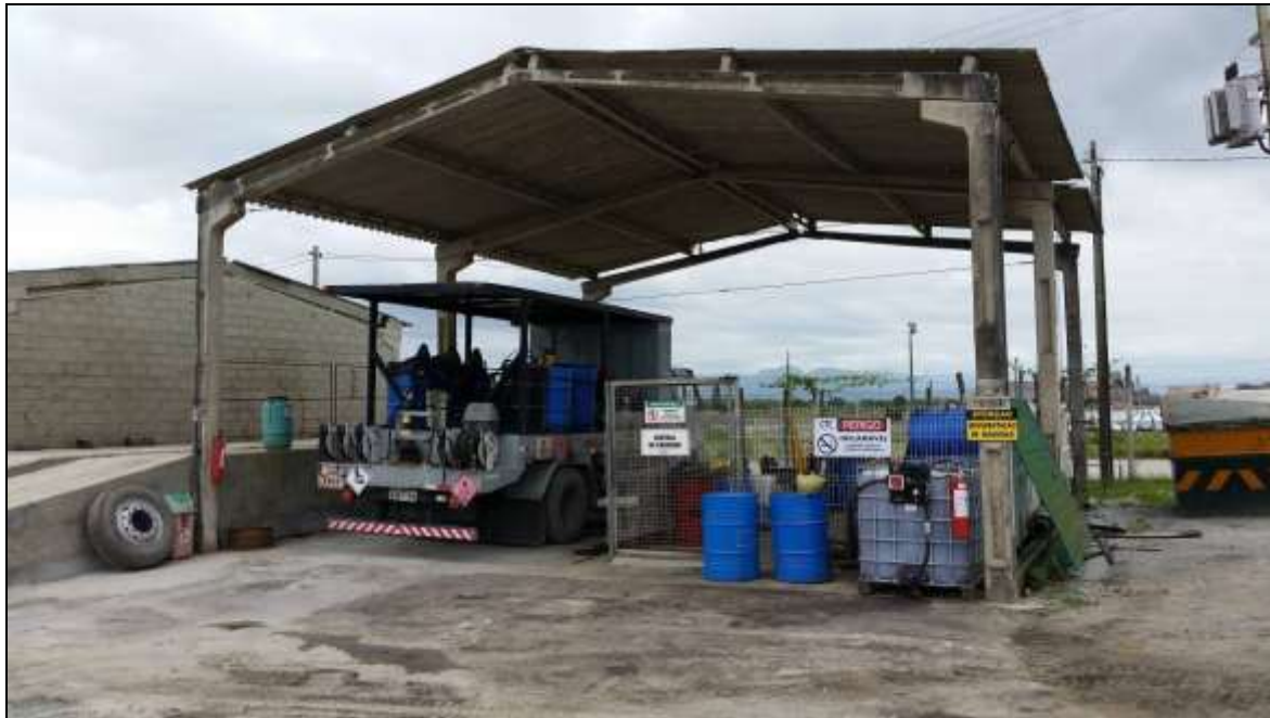
Figura 50. Imagem da Central de Resíduos Perigosos e Estacionamento do Caminhão Comboio.
