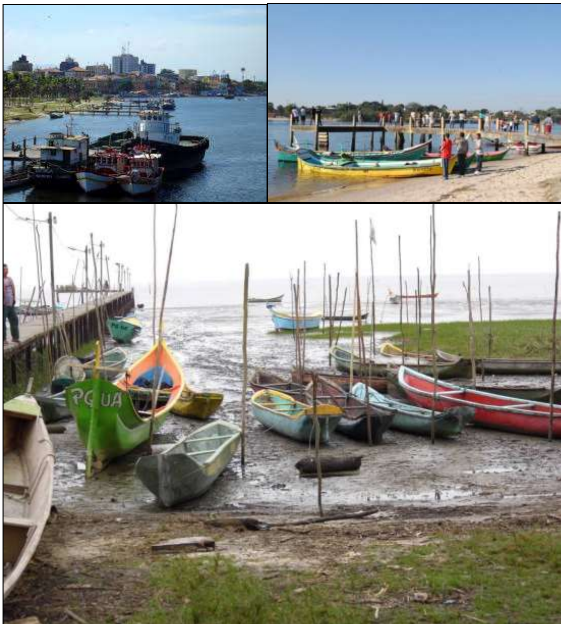
Figura 581. De cima para baixo, da esquerda para direita: trapiches no rio Itiberê (Paranaguá), local de atracação de canoas no município (margem do rio Itiberê) e trapiche na comunidade de São Miguel.
