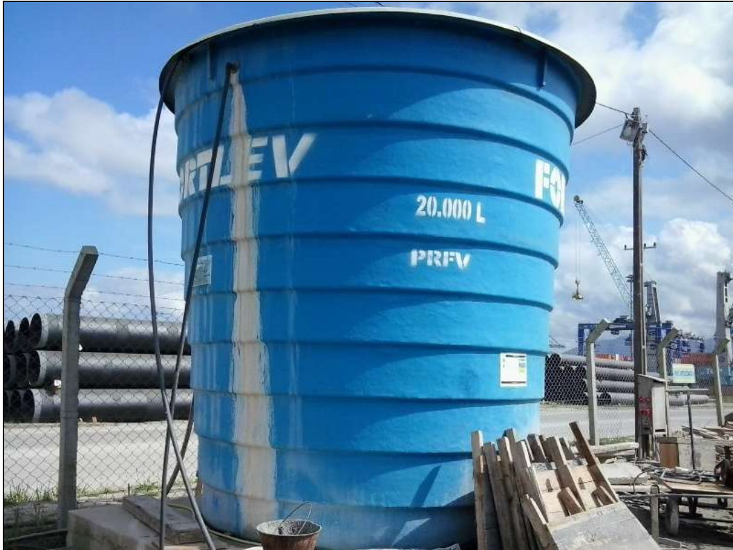
Figura 49. Tanque de armazenamento de água a ser reaproveitada na usina de concreto.
