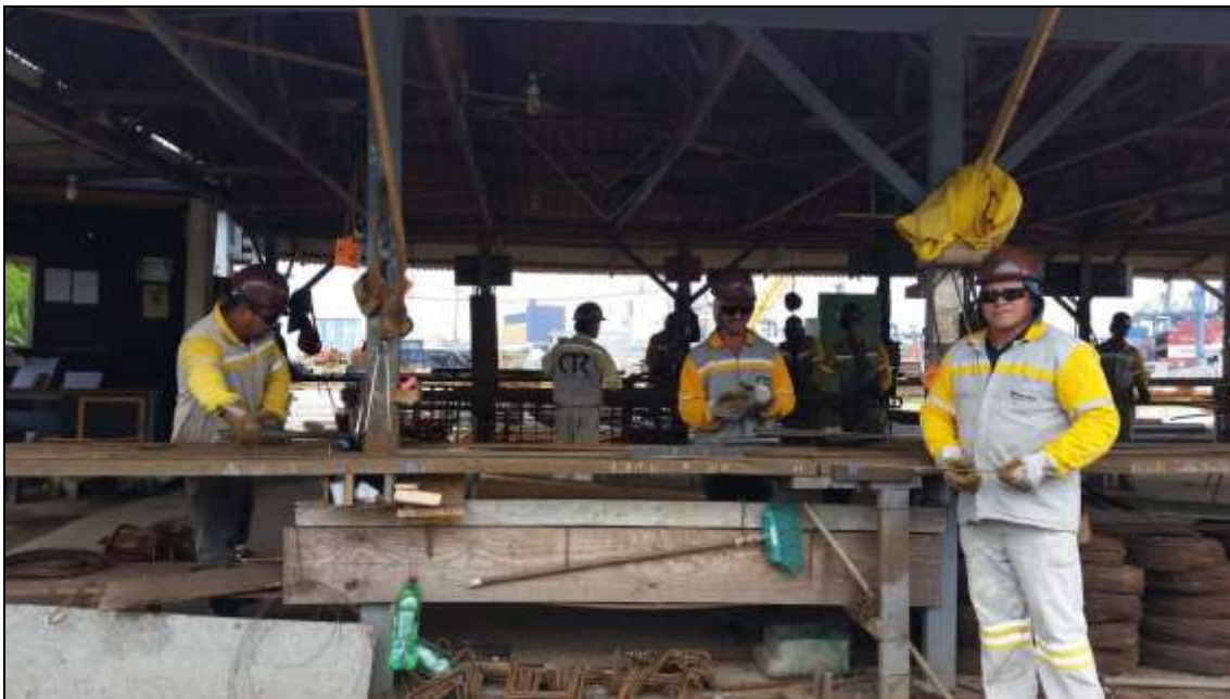
Figura 52. Local de corte e dobra de estruturas de ferro.
