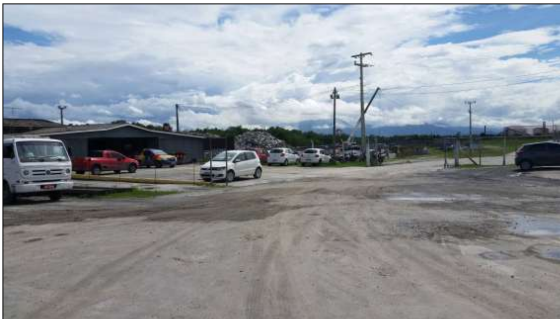
Figura 44. Acesso ao canteiro de obras e área de estacionamento para os operários e demais colaboradores.
