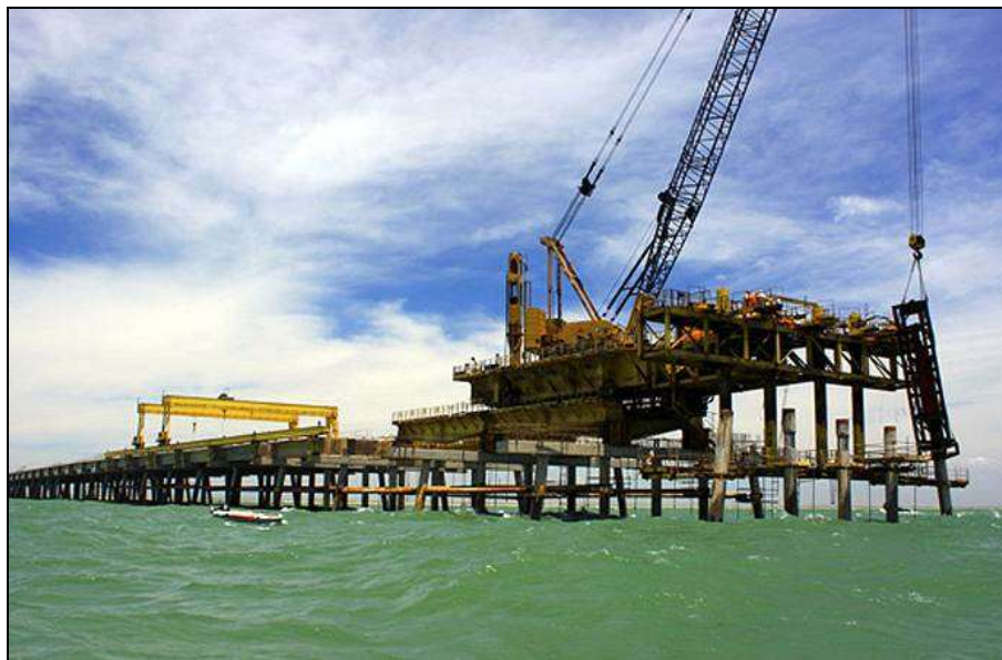
Figura 18. Bate estacas tipo Cantitravel .
