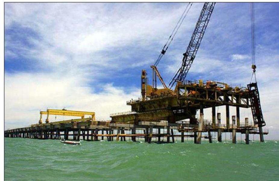
Figura 18. Bate estacas tipo *Cantitravel*.
