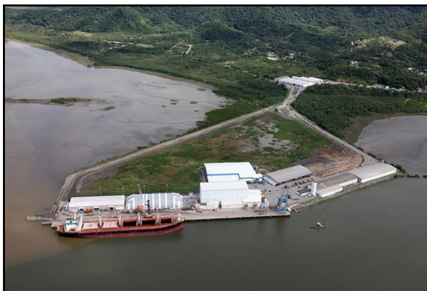
Figura 1 – Imagem aérea do terminal.
