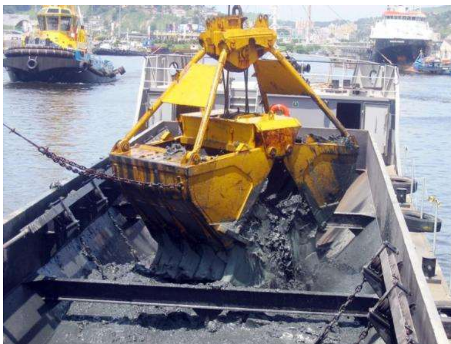
Figura 3.34 – Dragagem com caçamba de mandíbulas
