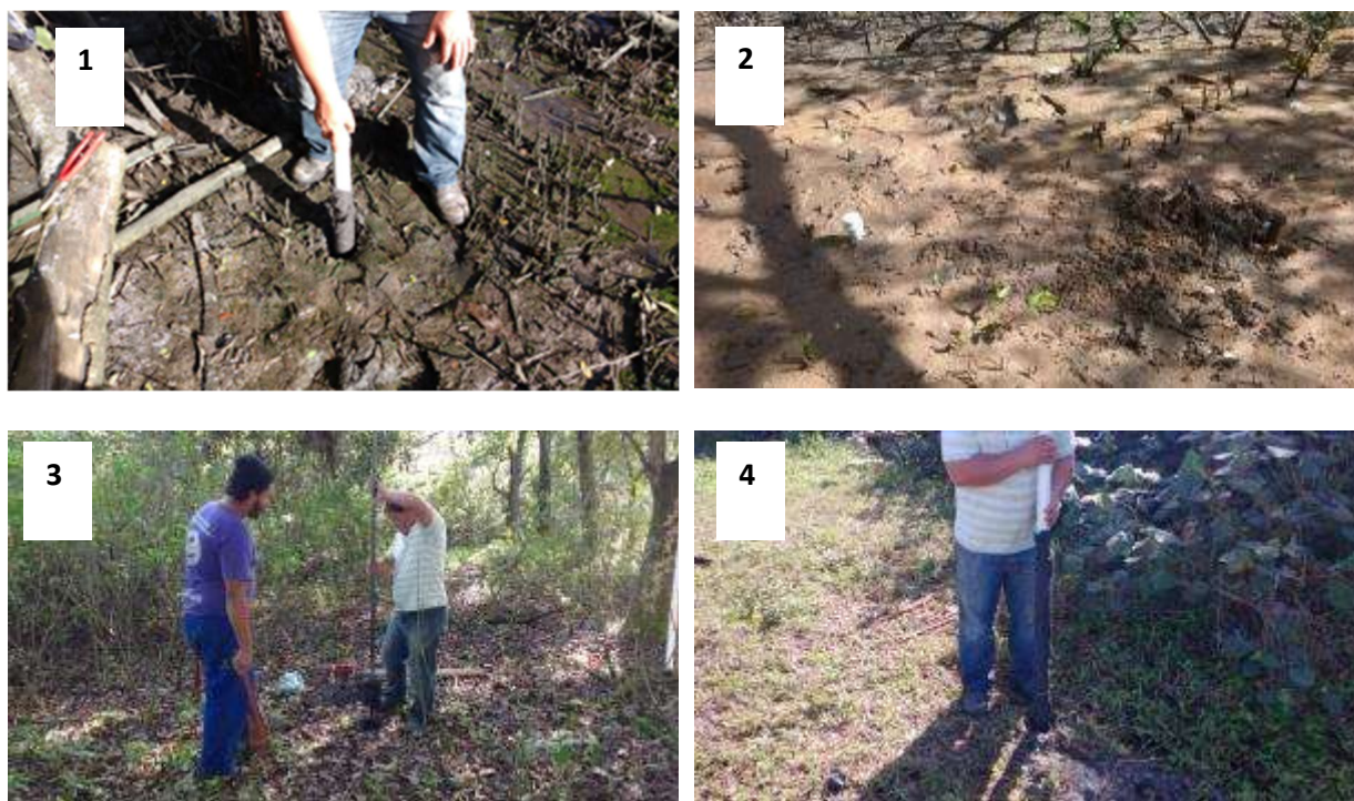
Figura 8.67 – Sequência de atividades desenvolvidas durante a instalação dos poços de monitoramento. Em (1) instalando coluna de revestimento do PM-01, pode-se perceber vegetação de mangue. Em (2) PM-01 já instalado. Em (3) perfuração com trado. Em (4) PM-05 sendo instalado.
