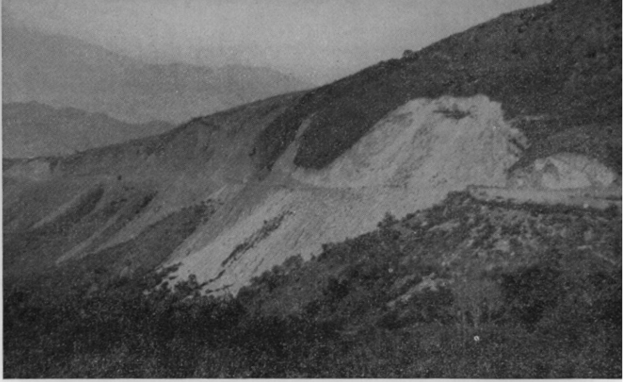
Fig. 21 — Degradação gerada pela construção de rodovia mal traçada, perto de Santa Ana, Venezuela.
