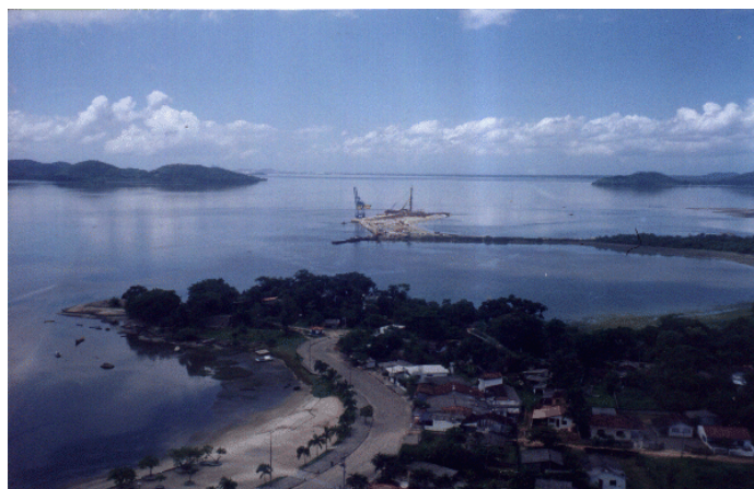
Figura 7.5.3.3.1 - Vista Geral do Canal de Antonina.
