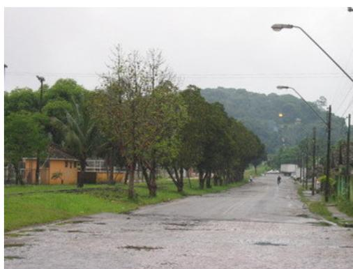
Figura 2.5.2.13 – A Avenida Conde Matarazzo, apesar de seu uso intenso por veículos pesados que vão ao porto, seu substrato e seu revestimento se encontram em melhores condições, apresentando alguns recalques.
