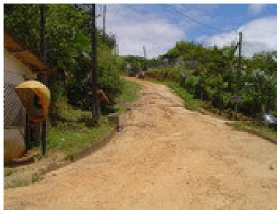
2.5.2.12 – Travessa Guarapirócabá, via com traçado e declividades equivocados, substrato mal executado e sistema de drenagem impróprios. Seu revestimento praticamente não existe em alguns pontos.
