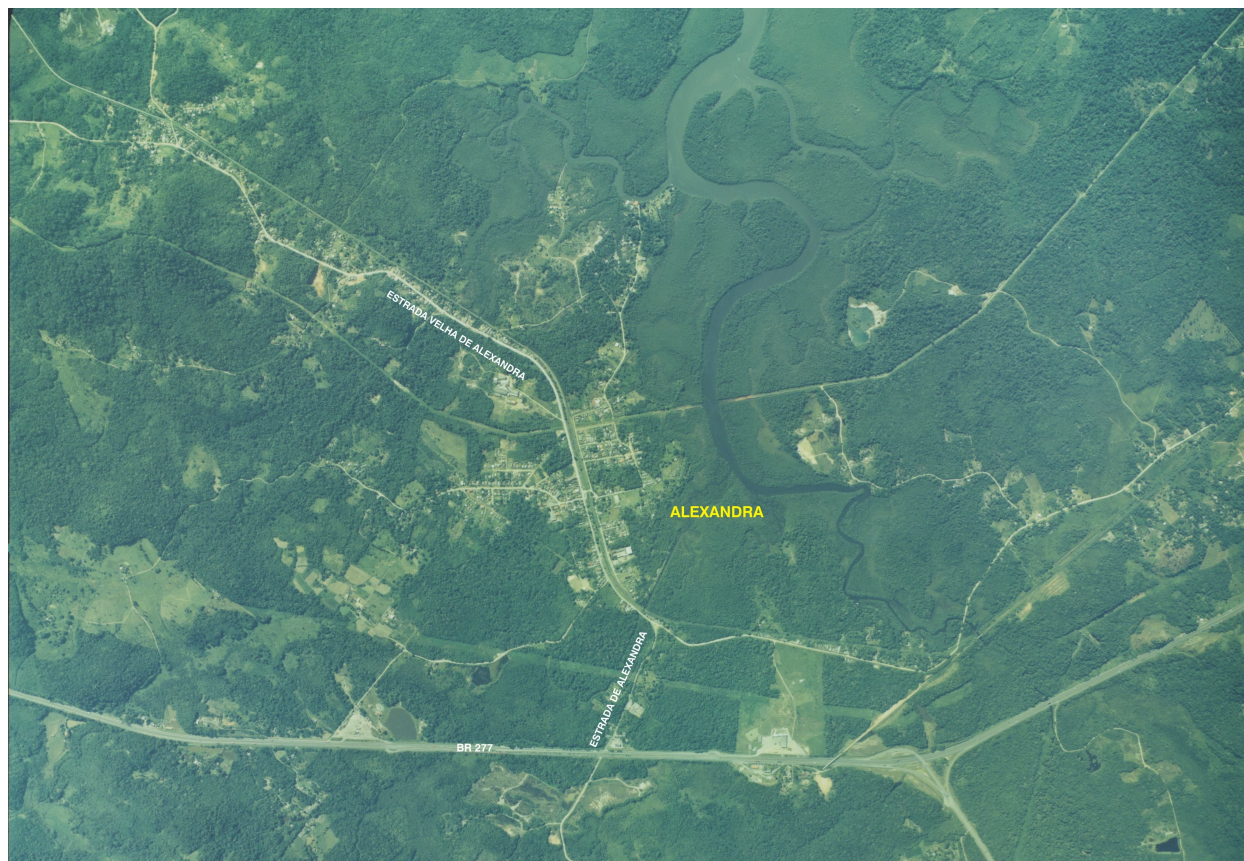
Figura 7 - Foto Aérea 2003 – Sede urbana de Alexandra
