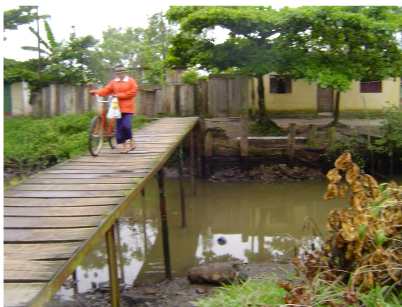
Foto 21 e Foto 22 - Canal da Anhaia – fossas e ponte improvisada
