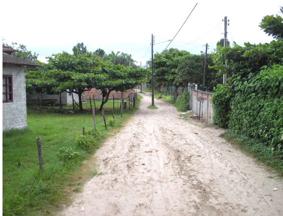
Foto 44 - Conflito entre vias de acesso e postes de energia elétrica
