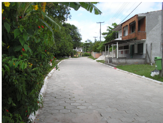
Foto 49 - Vias de acesso
