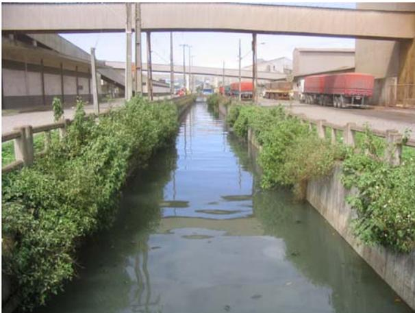
*Foto 4.1.12.1.1.2-1 – Vista parcial da galeria de águas pluviais contaminada com esgotos sanitários de redes clandestinas – Avenida Portuária*
