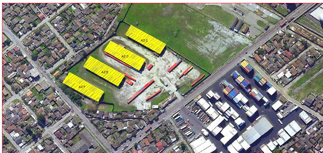
Figura 146. Localização dos armazéns para demolição na Vila da Madeira Fonte: APPA (2014)
