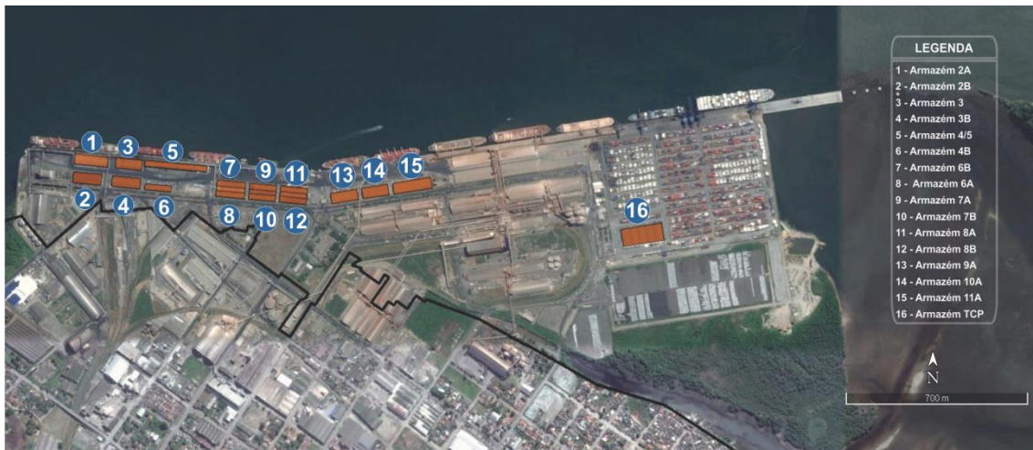
Figura 10. Vista aérea dos armazéns do Porto de Paranaguá
