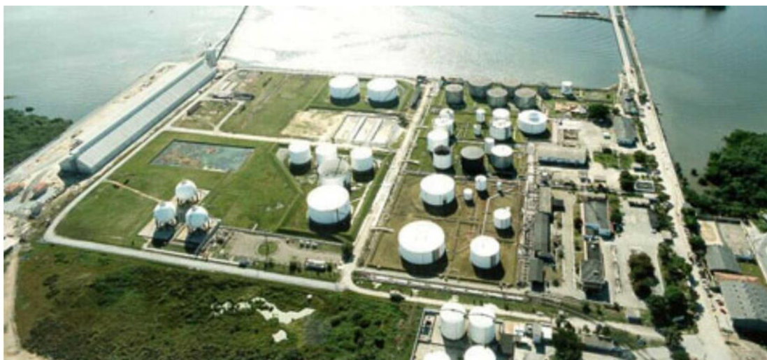
Figura 17. Tanques do terminal da Transpetro no Porto de Paranaguá
