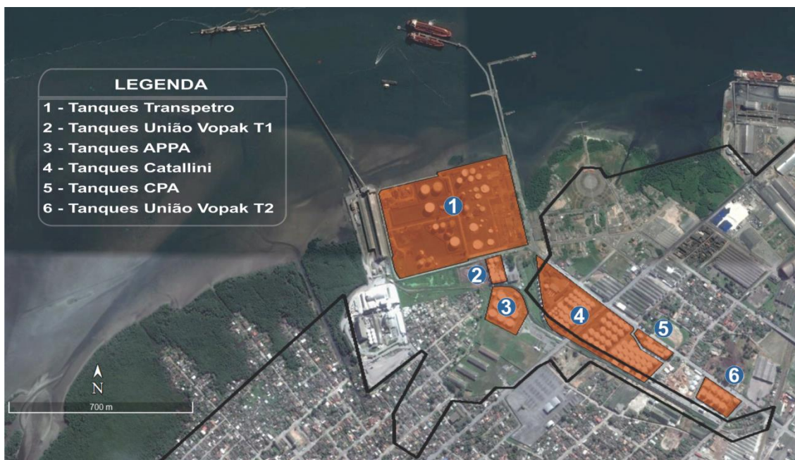
Figura 16. Vista aérea dos tanques do Porto de Paranaguá
