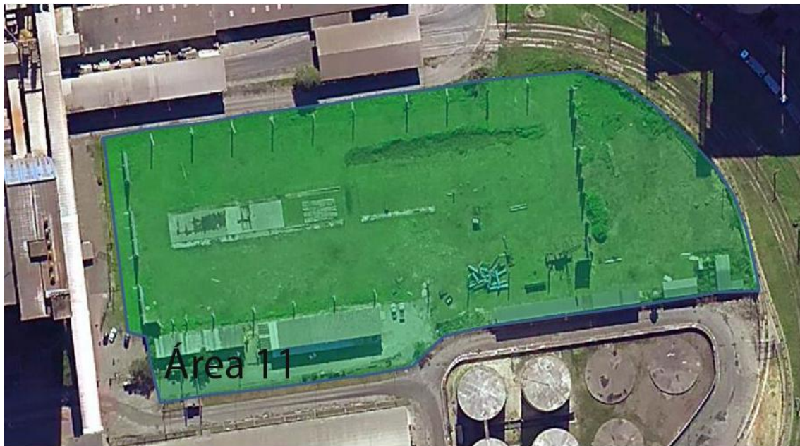
Figura 59. Área 11 - Terminal para granéis sólidos COREX
