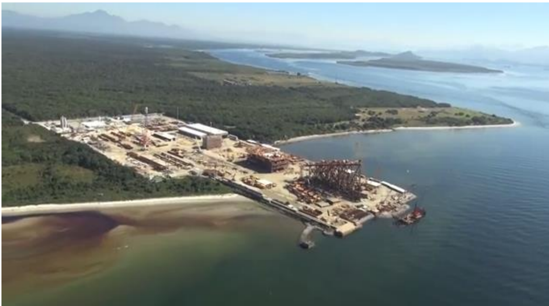
Figura 71. Infraestrutura de atracação da unidade offshore Techint
