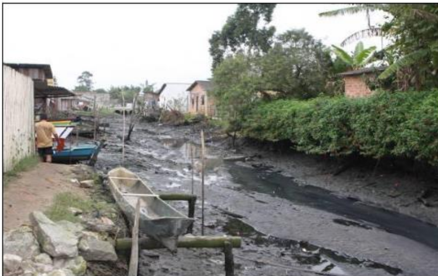
Figura 127. Ocupação irregular e lançamento do esgoto em rio ao lado do porto.
