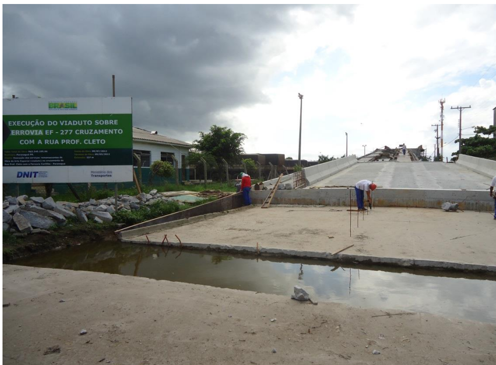
Figura 109. Viaduto sobre a linha férrea na Avenida Prof. Cleto
