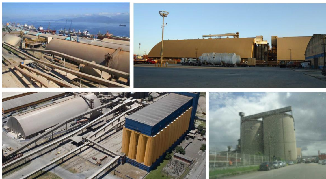
Figura 15. Silos do Porto de Paranaguá
