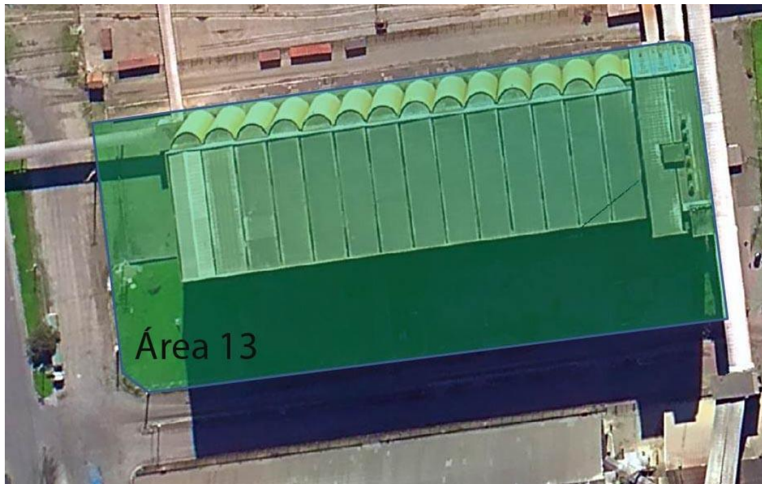
Figura 62. Área 13 – Silo Público Vertical (Silão) – Granéis sólidos para exportação Fonte: APPA (2013)
