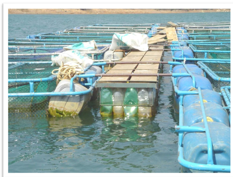
Figura 21 - Garrafas PET empregadas como estrutura de flutuação de tanque-rede.
