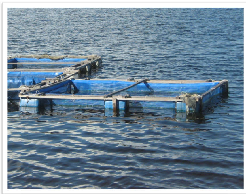
Figura 20 - Estrutura de madeira empregada na sustentação de tanques-rede de pequeno volume.
