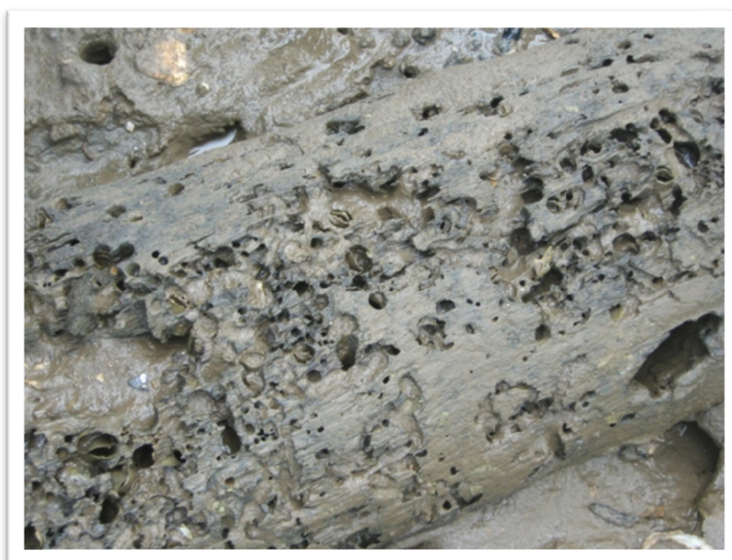
Figura 42 - Estaca de madeira degradada pelo molusco gusano ( Teredo sp.).
