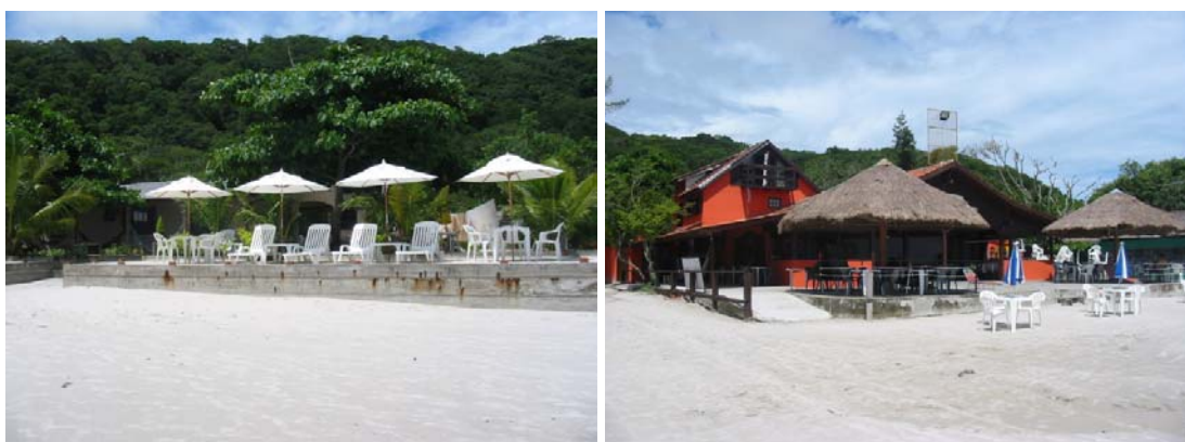
Figura 6 Construções à beira mar avançam sobre a praia
