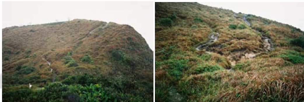
Figura 31 Ravinamento originado pelo escoamento superficial, após a destruição da vegetação nas trilhas, no morro de Encantadas.
