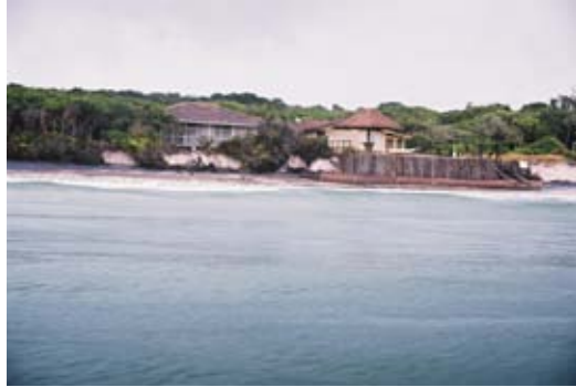
Figura 44 Muro vertical longitudinal à praia construído com troncos (paliçada) na parte norte da enseada das Conchas onde em 2003 se verificava intenso processo de erosão costeira. Notar o avanço do processo erosivo nas laterais da área com contenção.
