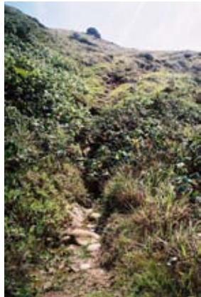
Figura 46 Trilha no Morro do Sabão (extremo leste do Morro Bento Alves) transformada em ravina pelo escoamento superficial.
