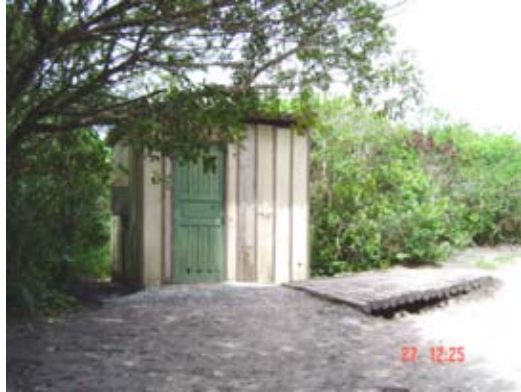
Figura 51 Bateria de Poço Semi-artesiano na Praia do Farol
