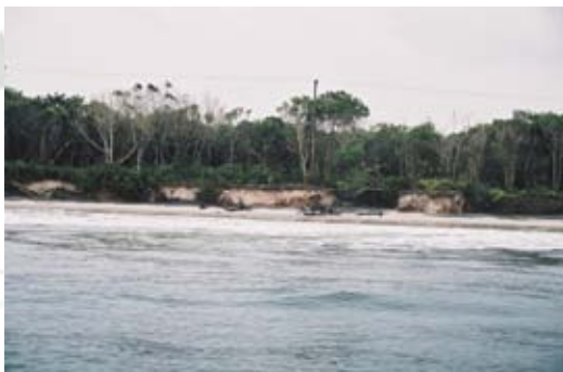
Figura 10 Escarpas erosivas da planície costeira entre Nova Brasília e a Fortaleza.
