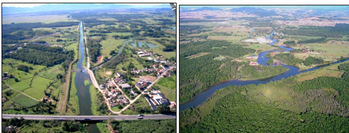
Figura 22: vistas aéreas do canal de derivação do rio Cubatão nos sentidos jusante (esquerda) e montante (direita), nos pontos de sua separação e reunião ao leito natural do rio, respectivamente. Fotos: F.A. Oliveira, 2006.
