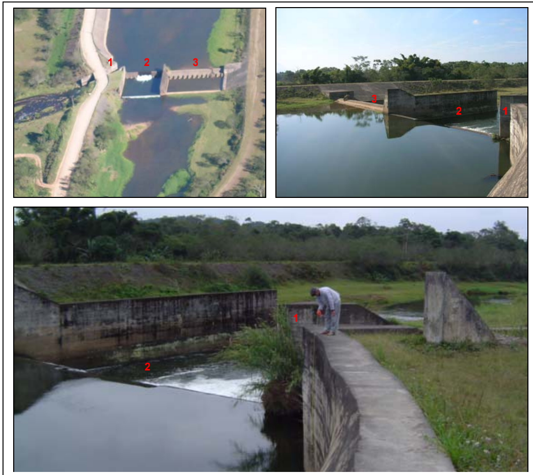
Figura 40: vertedouros n os 1, 2 e 3 na barragem do rio Cubatão, em vista aérea (superior esquerda) e oblíqua (superior direita). As medidas de altura da coluna d'água foram efetuadas junto ao vertedouro n o 1 (foto inferior). Fotos: F.A.Oliveira, 2004-2006.
