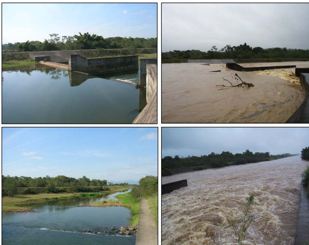
Figura 97: barragem do canal de derivação do rio Cubatão em momentos de vazão média (esquerda) e de grande pico de vazão (direita). Fotos: Oliveira, 2006; CCJ, 2001.
