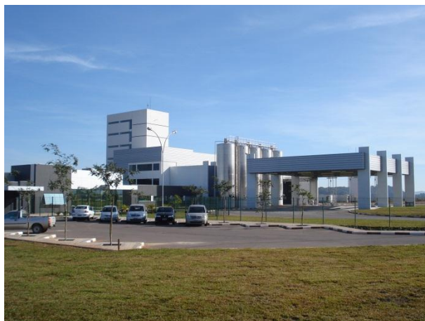
Figura 2 Usina de Beneficiamento de Leite da Cooperativa Castrolanda, em Castro/PR.
