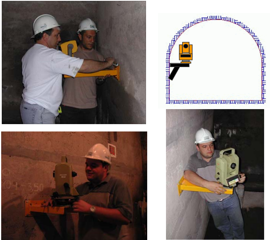
Figura 3.2 – Ponto em estrutura na lateral de uma galeria.
