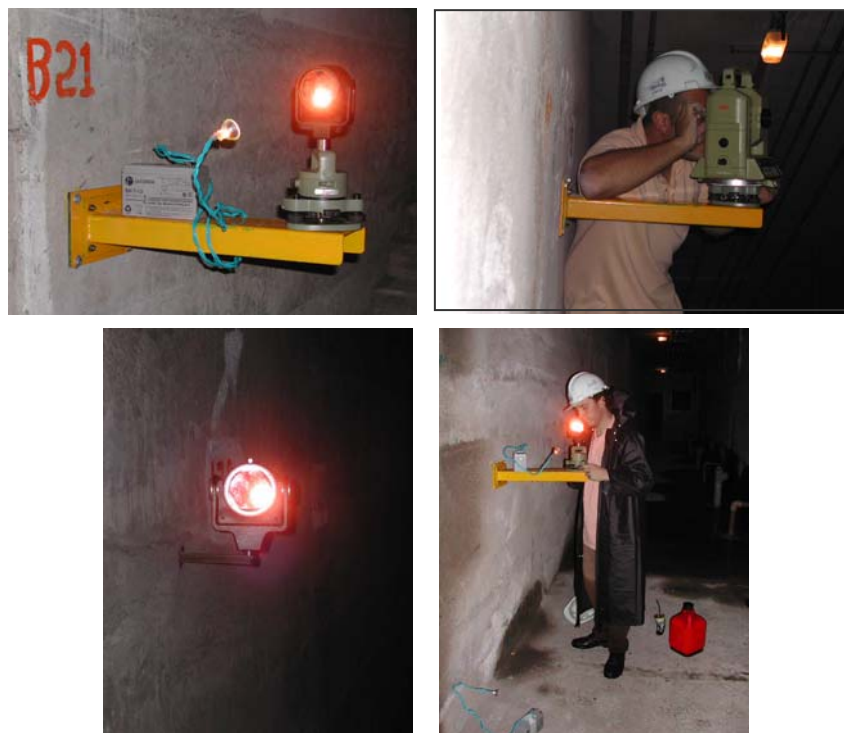
Figura 1.5 - Sistema de iluminação.
