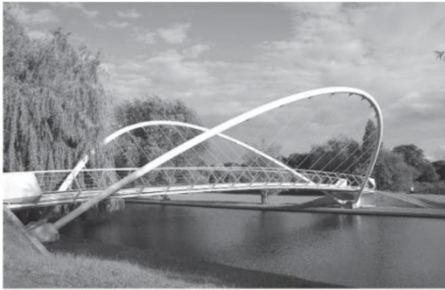
Esta ponte em arco parabólico suporta o tabuleiro acima dela.
